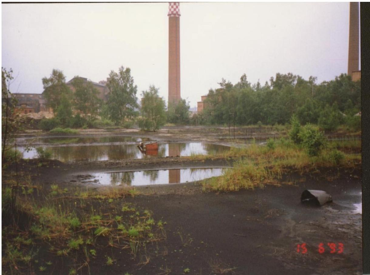
**Abb. 9.8.1: Teerseen (Zustand 1993; im Hintergrund links: Ruine der ehemaligen Gasgeneratorenanlage**
