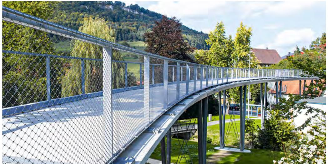
**K**ohlenstofffasern, die dünner als ein menschliches Haar sind, bilden die Grundlage des bereits mehrfach preisgekrönten Verbundbaustoffs – Carbonbeton. Eine Kombination aus Hochleistungsbeton und Carbonfasern, die zu einem Gelege oder einem Stab verarbeitet werden, dient dabei als Bewehrung.
