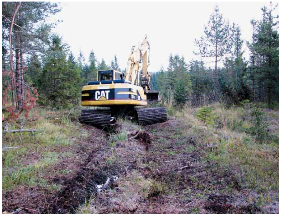
Bild 11.4: Baggereinsatz zur Moorrenaturierung
