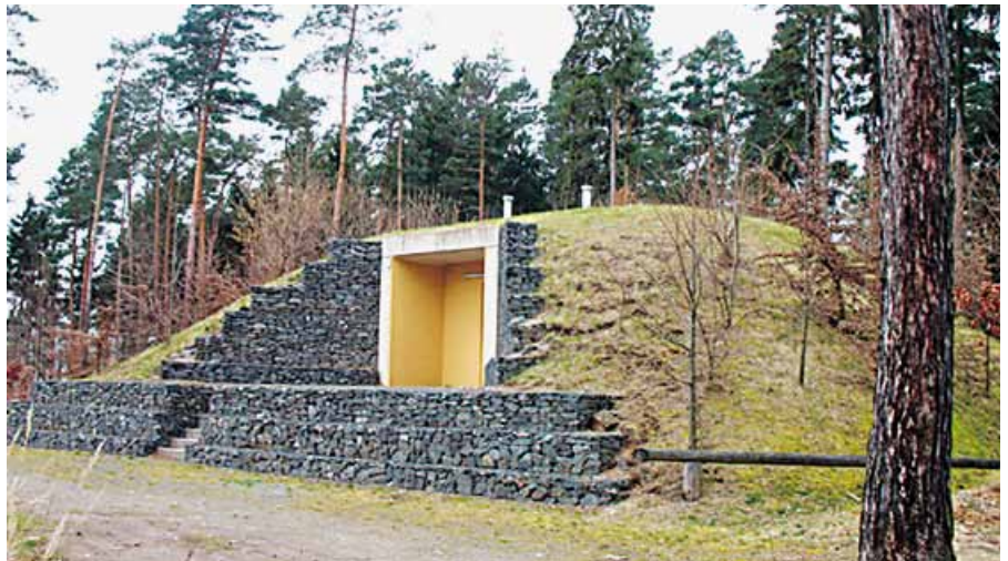
Bild 6.7: Wasserschutzgebiet mit Wassergewinnungsanlage im Wald
