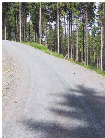
Bild 5.5: Geförderter Bau eines forstwirtschaftlichen Weges
