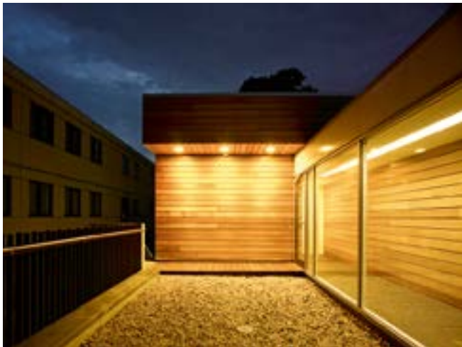
Erweiterungsbau des Ruderclubs Dresden Cotta; Durch die Verwendung von Holz konnten die Raumeinheiten statisch unproblematisch auf die vorhandene Bausubstanz aufgebaut werden.
