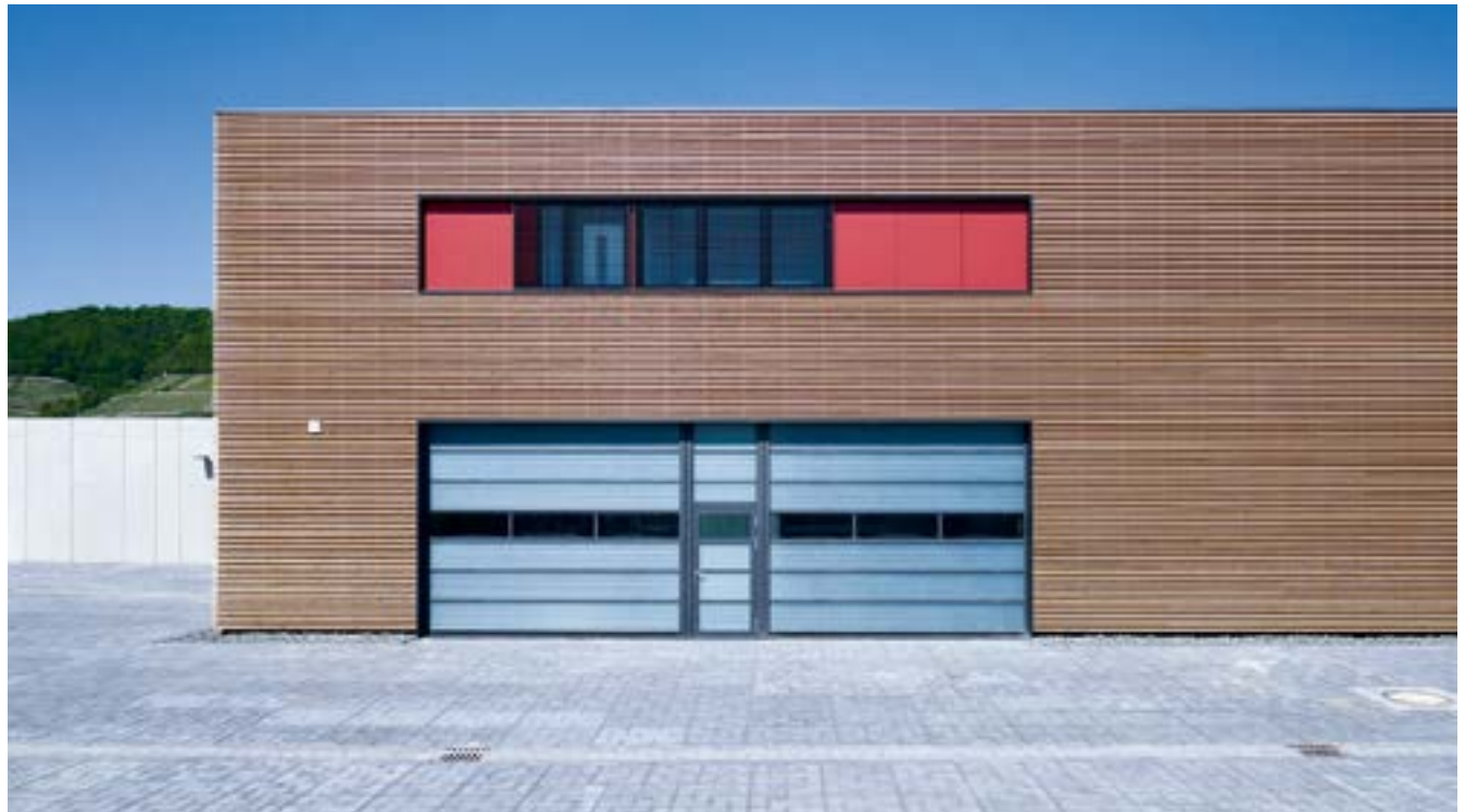
Holzaußenverkleidung Mehrzweckhalle des Landesamtes für Umwelt, Landwirtschaft und Geologie in Pillnitz.
