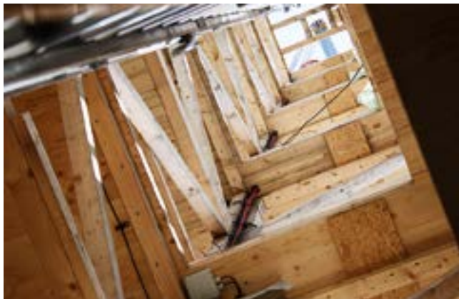
Der TimberTower bei der Aufstellung (rechts), Innenansicht in den späteren Fahrstuhlschacht (unten links), fertige Anlage (oben).
