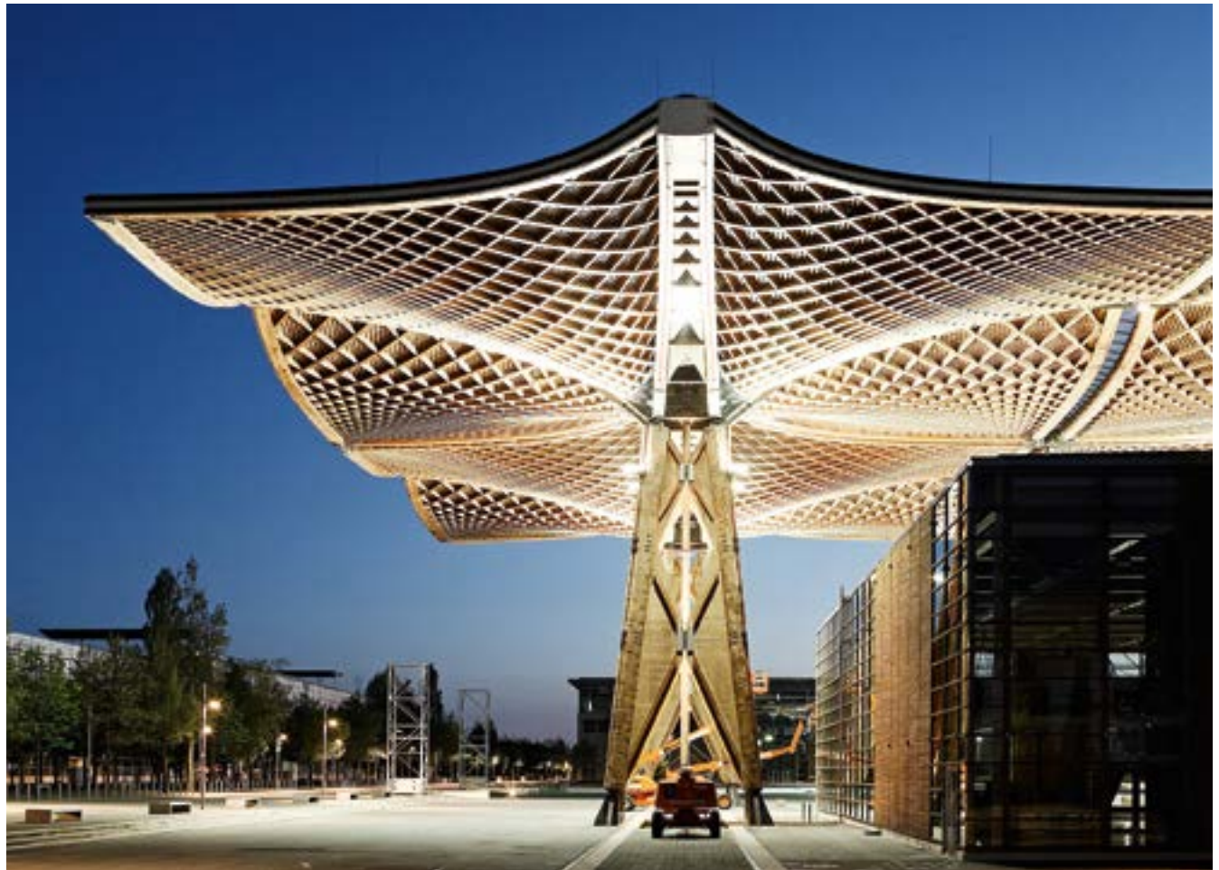
Ansichten des EXPODACHs mit den doppelt gekrümmten Schalenflächen der Schirme.
