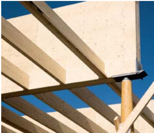
Außenansicht der fertigen Sporthalle (oben) und außenliegende Dachträger in der Bauphase (unten).
