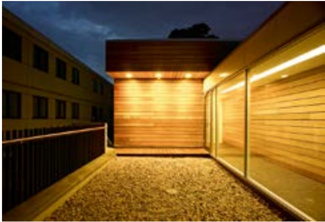
Außen- und Innenansichten Ruderverein Dresden Cotta.
