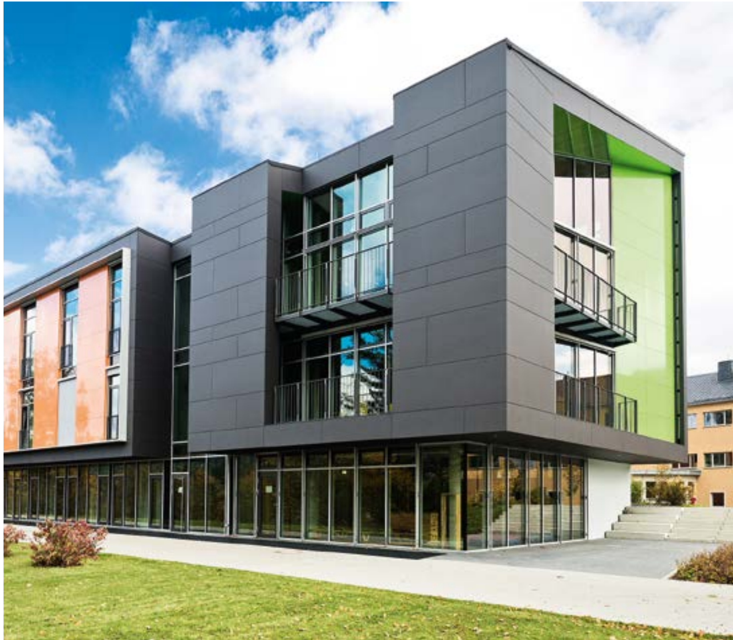
Außenansicht des mit Hochdruck-Schichpressstoffplatten verkleideten Sportinternats Klingenthal.
