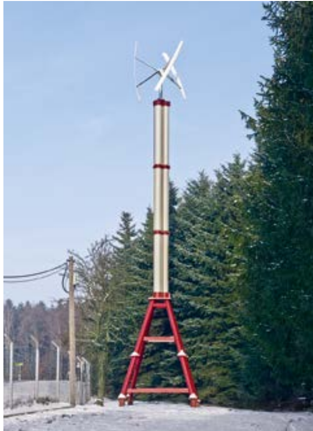
Erste in Sachsen aus Formholz errichtete Windkraftanlage mit einer Höhe von 18 m und einer Leistung von 1kW; Zum Schutz vor Witterung wurde eine graue Beschichtung aus Polyesterharz aufgebracht. Für die drei grauen Röhren mit insgesamt 27 m Länge wurden nur 0,5 m 3 Fichtenholz benötigt
