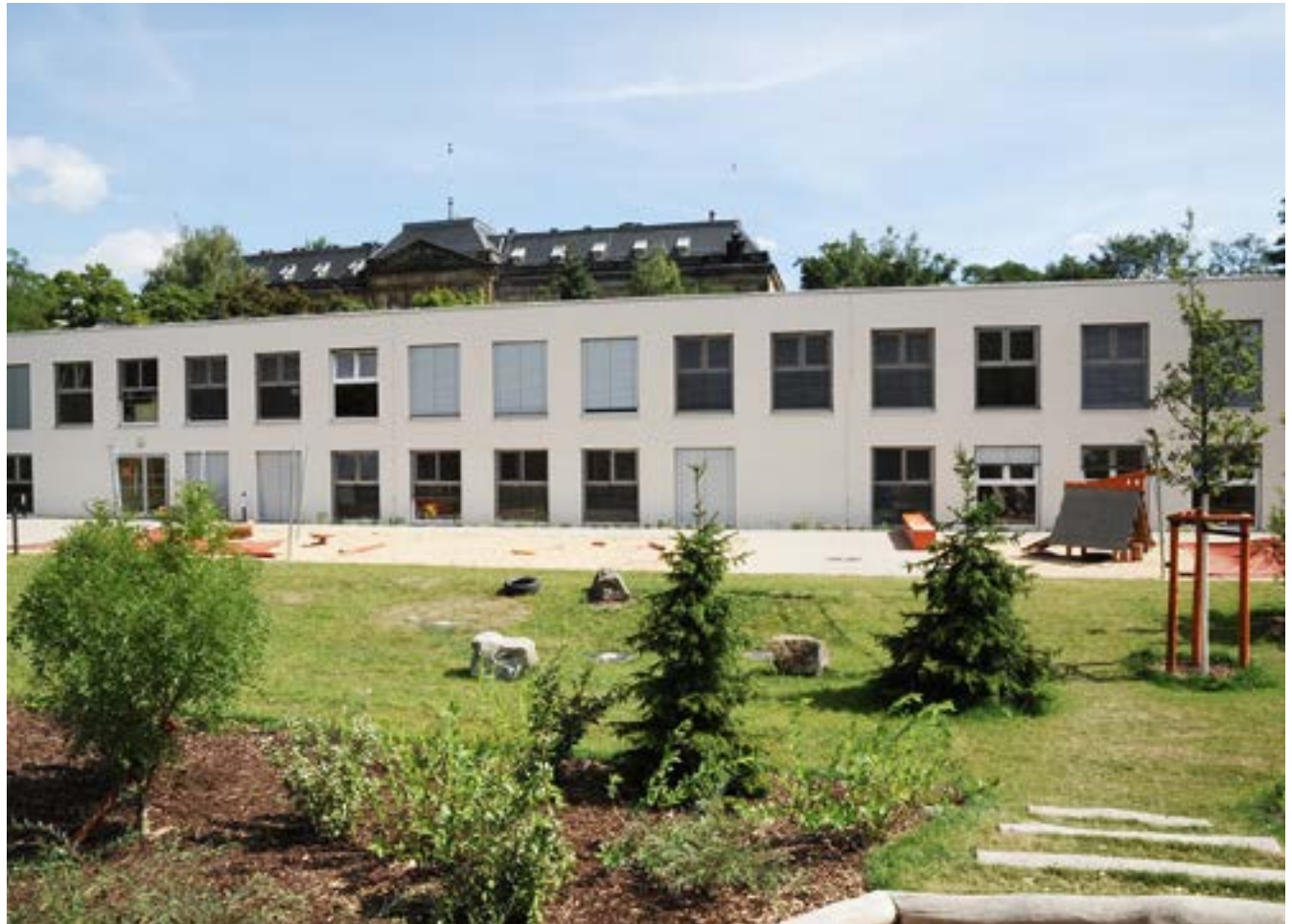
Weder von außen noch von innen ist der Kindertagesstätte in der Fabricestraße als Holzbauweise zu erkennen.
