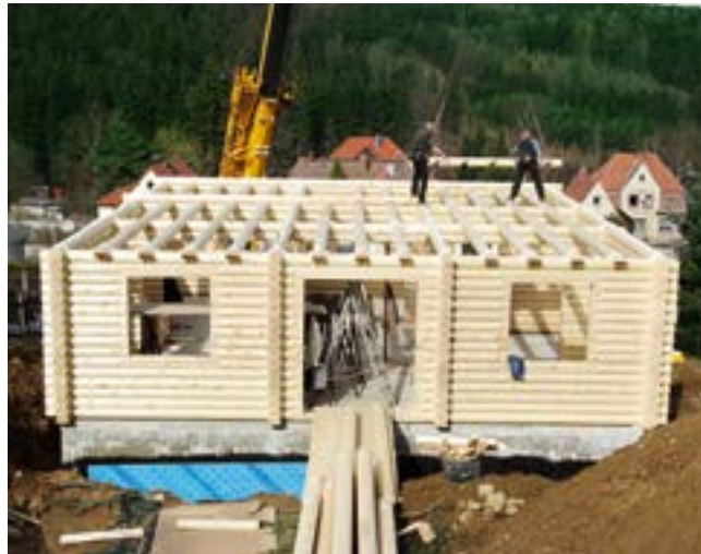
Blockbauhaus in der Bauphase.
