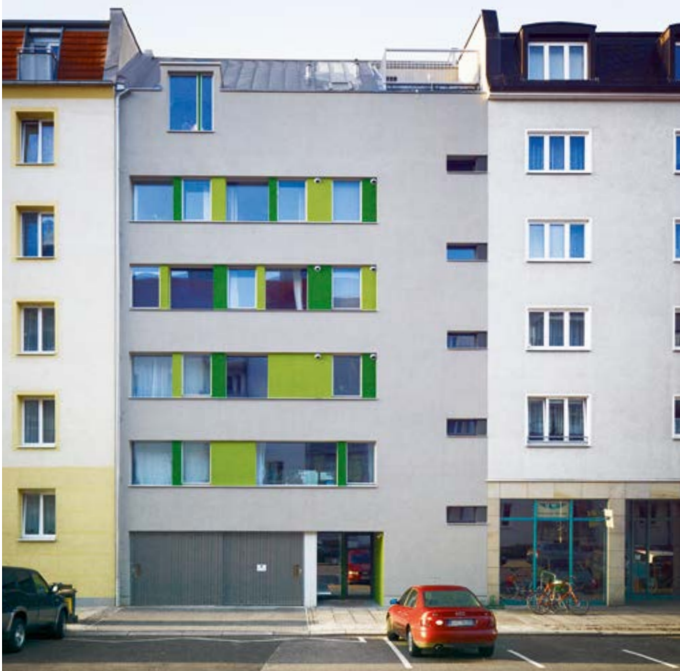
Mehrgeschossige Lückenbebauung in Holzbauweise in Dresden.
