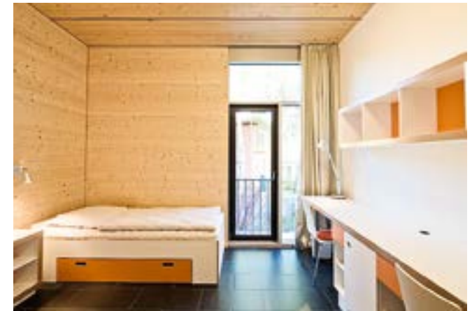
Internatszimmer mit sichtbarer Holzoberfläche der Brettstapelelemente.
