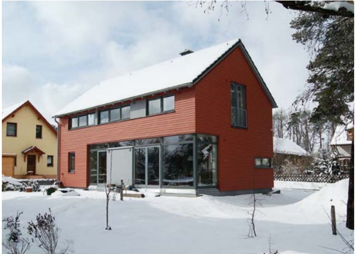
Niedrigenergiehaus Dresden (links und oben). Einfamilienhaus in Holzrahmenbauweise und Holzaußenverkleidung (rechts).
