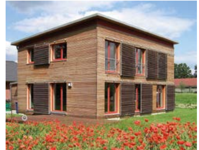
Sommerlicher Wärmeschutz ist bei Bauwerken aller Materialien entscheidend, um ein übermäßiges Aufheizen in der warmen Jahreszeit zu verhindern. Hier eine ausgezeichnete Lösung mittels verstellbarer, außenliegender Holzlamellen. Damit bleibt die Wärme draußen, es gelangt aber noch ausreichend indirektes Sonnenlicht zur Beleuchtung der Räume ins Innere des Hauses.
