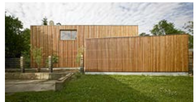
Haus in Holzrahmenbauweise mit Lärchenholzverkleidung.
