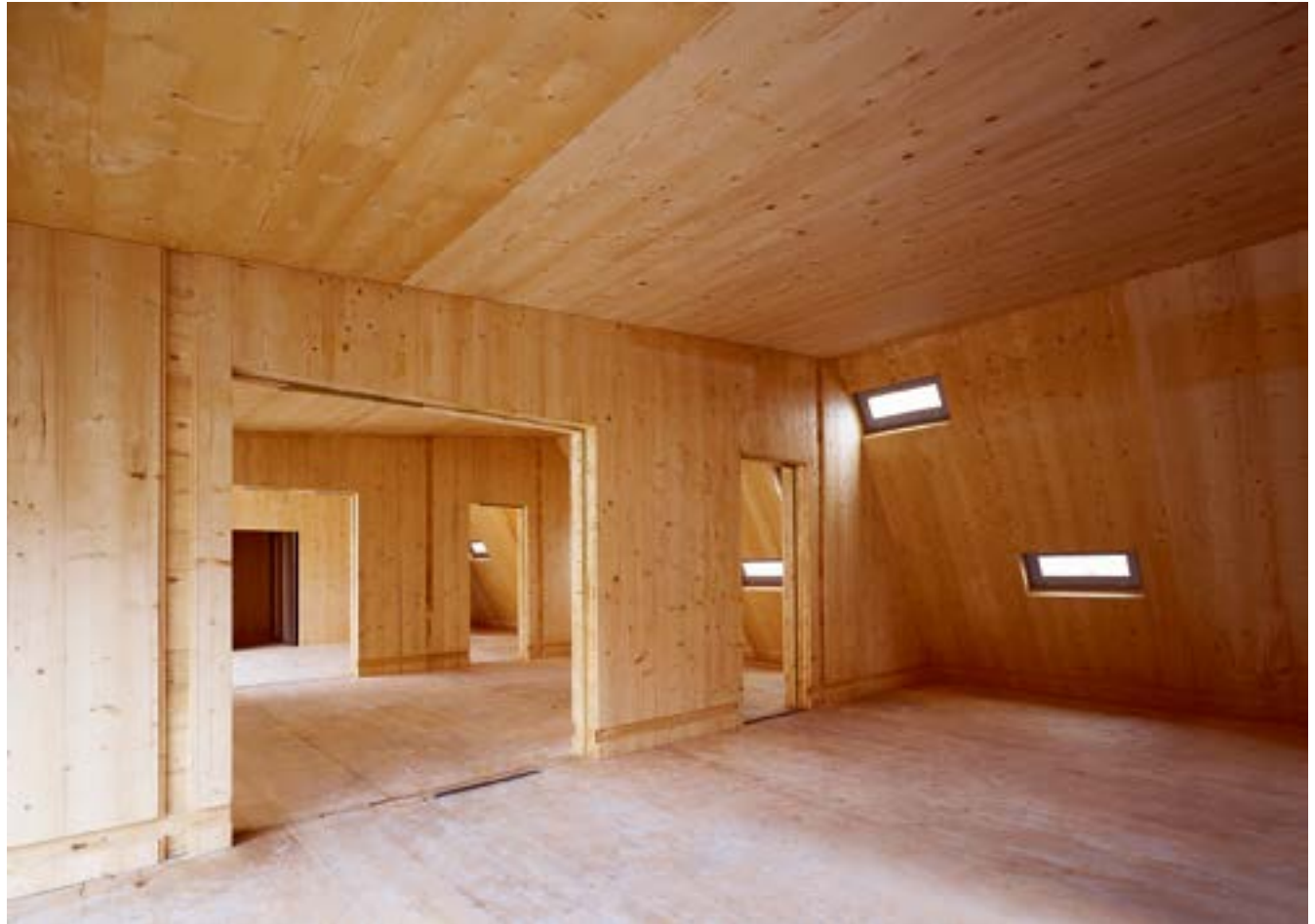
Innenansicht einer Holzbaueise aus Brettstapelelementen.
