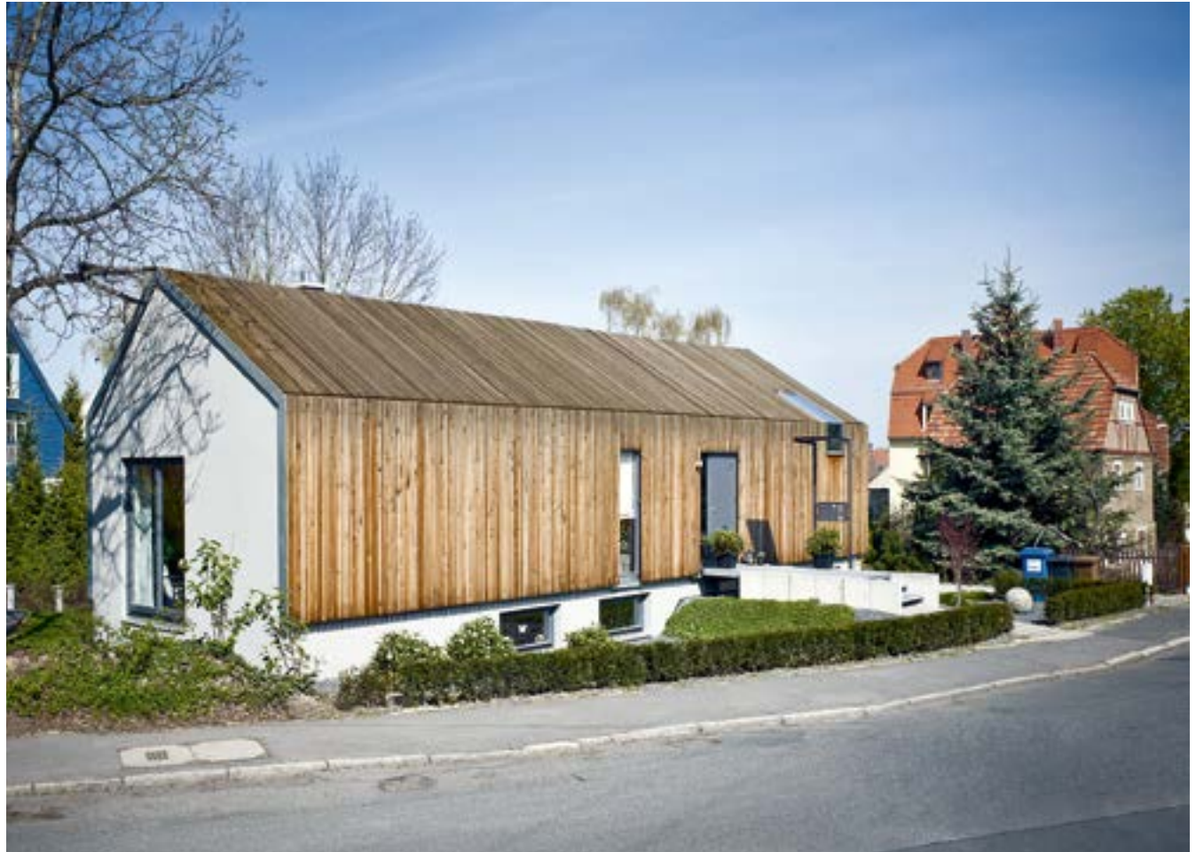
Außenansicht eines Einfamilienhauses in typischer Hausbauform in Dresden (oben). Innenansicht mit offen sichtbaren Holzdecken und -wänden (rechts).
