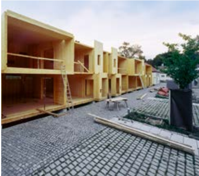
Brettsper Holzbauphase des Atelierhauses der Deutschen Werkstätten in Dresden Hellerau in der Bauphase.
