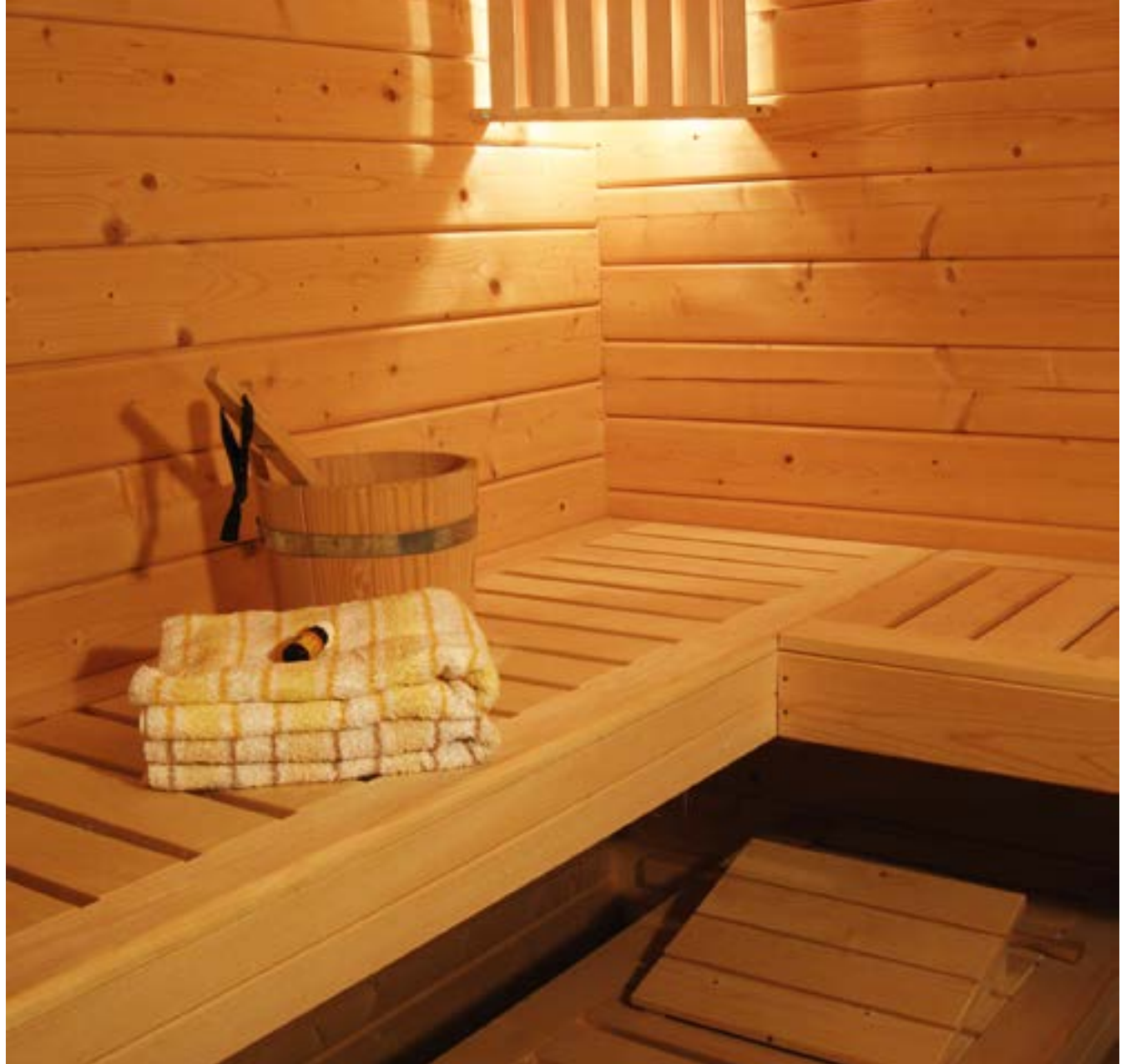
Für den Bau einer Sauna finden traditionell langsam gewachsene Nadelhölzer Verwendung. Die Liegen hingegen werden aus ast- und splitterfreiem Holz der Aspe oder Erle gefertigt.
