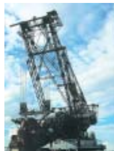
Bagr jako technický pomník v renaturalizované oblasti Berzdorfské jezero u města Görlitz
