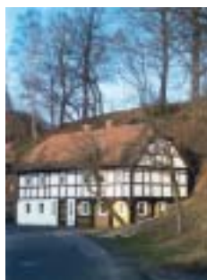
Hrázděný dům ve městě Niederoderwitz, Horní Lužice
