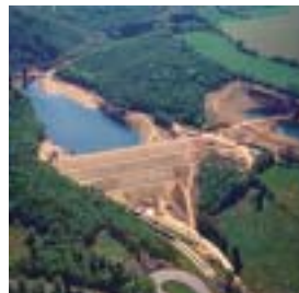
Retenční nádrž na zadržení povodní Lauenstein
