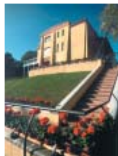
Escheho vila, Chemnitz, architekt: Henry van de Velde
