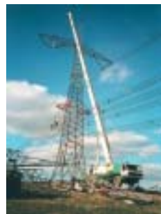
Společnost ABB provádí práce základní údržby dálkového vedení
