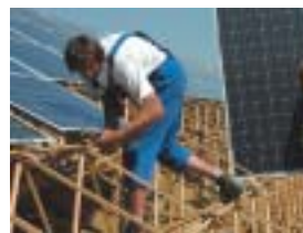
Montážní práce v solární elektrárně v Espenhainu
