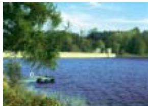
Barrage d'eau potable, Klingenberg
