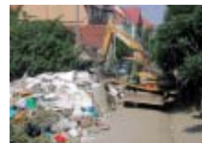
Après la crue : d'immenses montagnes de décombres parsèment la rue Seidelbaststraße dans le quartier Laubegast, à Dresde
