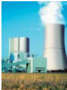
La centrale thermique au lignite Boxberg de la Vattenfall Europe AG & Co. KG
