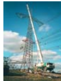
ABB effectue des travaux de maintenance de base sur le réseau des lignes à grand transport d'énergie
