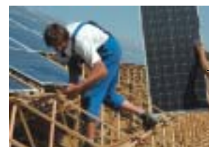
Travaux de montage au parc solaire d'Espenhain
