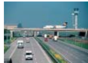
L'autoroute A14 près de Leipzig passe sous la voie de circulation de l'aéroport
