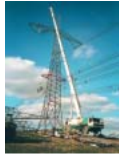
Trabajos de reparación en una línea de larga distancia por parte de ABB
