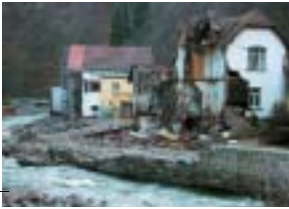
Destrozos causados en Weißeritz: Glashütte en los Montes Metálicos
