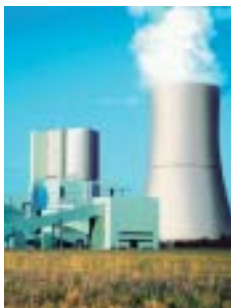
Central eléctrica de lignito en Boxberg (Vattenfall Europe AG & Co. KG)
