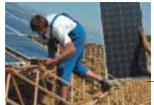
Montaje del parque solar de Espenhain
