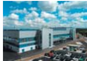
Nueva fábrica de láminas de silicio de 300 mm de Siltronic AG en Freiberg
