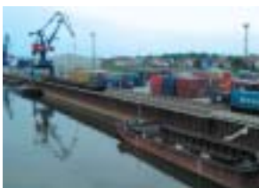
Puerto de Riesa preparado para ampliar la sección de contenedores
