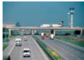
Cruce de la autopista A14 de Leipzig con la pista del aeropuerto
