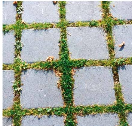
→ Das Rasenfugenpflaster ermöglicht die großflächige Entsiegelung.
