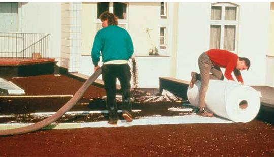
Manchmal ist die Filterschicht werksseitig bereits als Bestandteil in den Dränmatten integriert. Ansonsten werden Vliesstoffe oder Gewebe, aus denen die Filterschicht besteht, über der Dränschicht mit einer Überlappung von mindestens 10 cm flächig verlegt. Die Filter-
