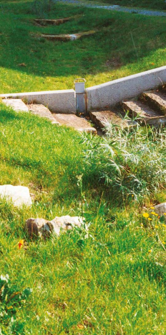
Eine **Versickerungsmulde** ist eine flache und meist begrünte Geländevertiefung, deren Form geometrisch oder frei gestaltet werden kann. Die Muldensohle wird eben und möglichst ohne Gefälle angelegt, damit eine gleichmäßige Versickerung bzw. langsame Ableitung erfolgen kann.
