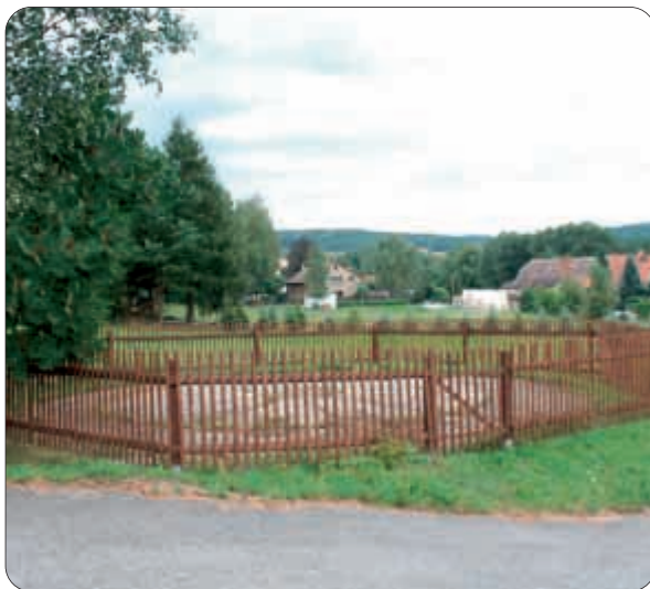
Kommunale Gruppenkläranlage Neubaustraße
