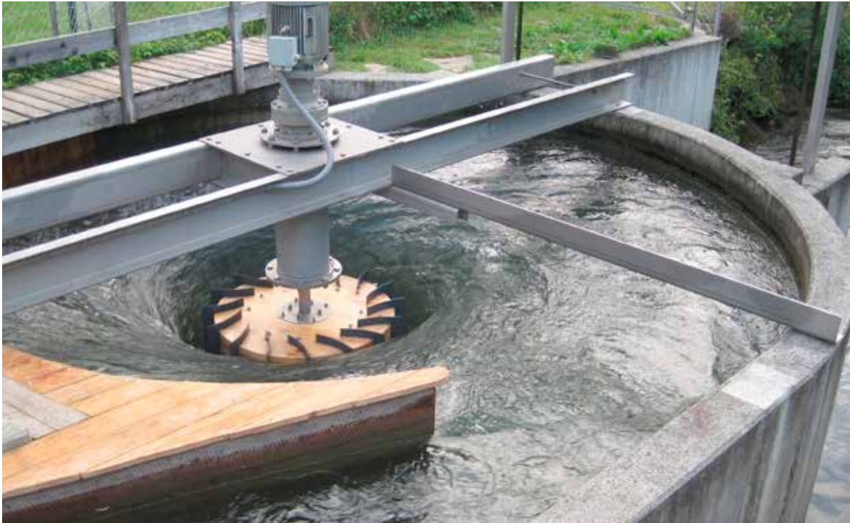
Abb. 29: Aufbau eines Wasserwirbelkraftwerkes [ZOT 2011]
