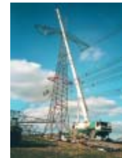
Prace konserwatorskie sieci wysokiego napięcia koncern ABB
