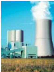
Elektrownia węgla brunatnego Boxberg Vattenfall Europe AG & Co. KG
