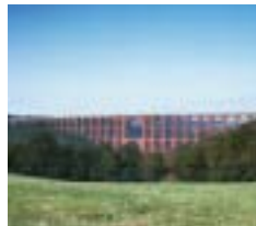
Najwyższy most ceglany świata – „Göltzschtalbrücke“ w Vogtlandzie
