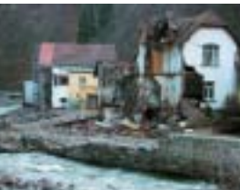
Niszczycielska Weißeritz: Glashütte, Rudawy
