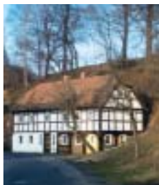
Dom o konstrukcji wiązanej w Niederoderwitz, Górne Łużyce
