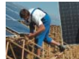
Prace montażowe w Espenhain
