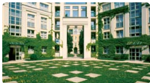
Entsiegelung durch Trittplattenbelag
