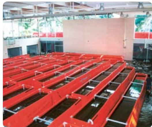
Flutung einer Turnhalle 2002 in Dresden zum Schutz gegen Aufschwimmen durch Grundwasseranstieg
