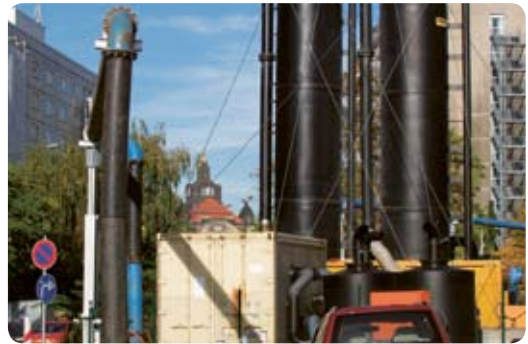
Verschmutztes Grundwasser aus einer Baugrube muss vor dem Einleiten in die Kanalisation oder einen Fluss gereinigt werden.
