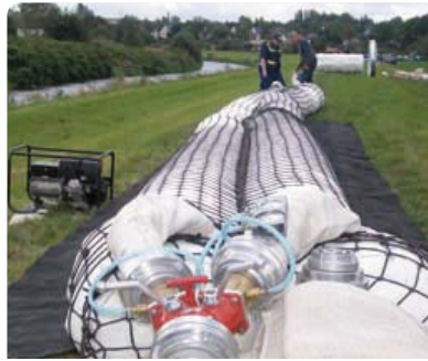
Abb. 30: Aufbau eines Quickdamm-Systems (Foto: LTV)
