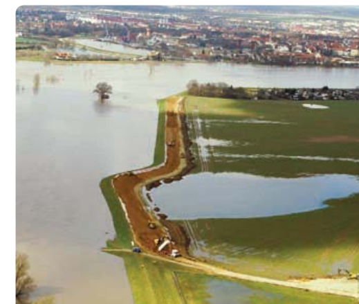
Abb. 16: Deichsicherungsmaßnahmen in Werdau bei Torgau, Foto: Dirk Laubner, Berlin
