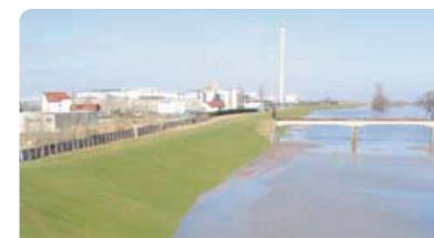
Abb. 11: Ertüchtigung eines Deiches an der Elbe in Torgau (im Hintergrund: Flachglaswerk Saint Gobain Gruppe) (Quelle: Hydroprojekt Ingenieurgesellschaft mbH)
