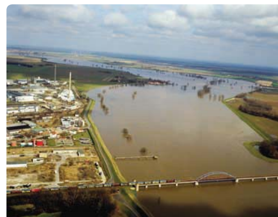
Abb. 12: Luftbild des ertüchtigten Elbdeiches in Torgau zum Hochwasser Frühjahr 2006, Foto: Dirk Laubner, Berlin
