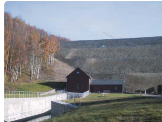
Abb. 18: HRB Lauenstein/Müglitztal – Absperrbauwerk (Quelle: SMUL)
