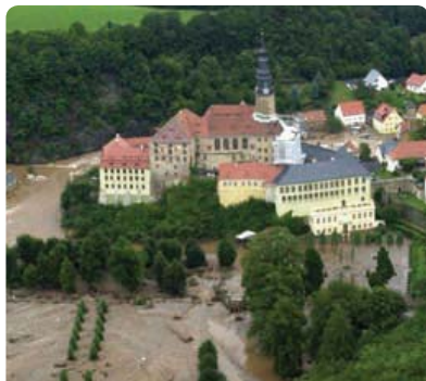
Abb. 1: Weesenstein nach dem Augusthochwasser 2002
