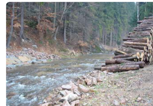
Abb. 23: Ablagerungen am Gewässer mit Gefahrenpotenzial bei Hochwasser
