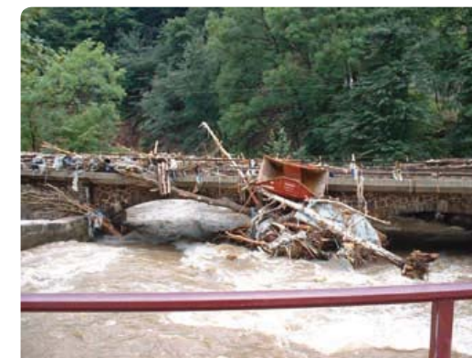
Abb. 13: Brückenverklausung
