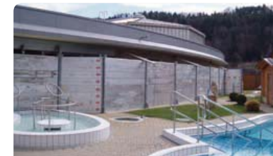
Abb. 31: Objektschutz der „Toskana Therme“ in Bad Schandau
