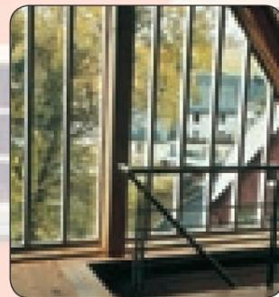
Der schlechte Bauzustand machte den kompletten Rückbau des Daches und des Obergeschosses erforderlich. Dies ermöglicht auch bei Beibehaltung der alten Trauf- und Firsthöhen ein offenes Konzept für die Nutzung. Der Dachraum gehört heute zum OG, der Lichteinfall über den verglasten Giebel ermöglicht eine optimale Nutzung.
