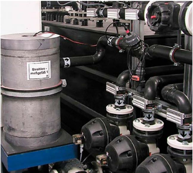
Strahlenschutzmessung an einer Abklinganlage
