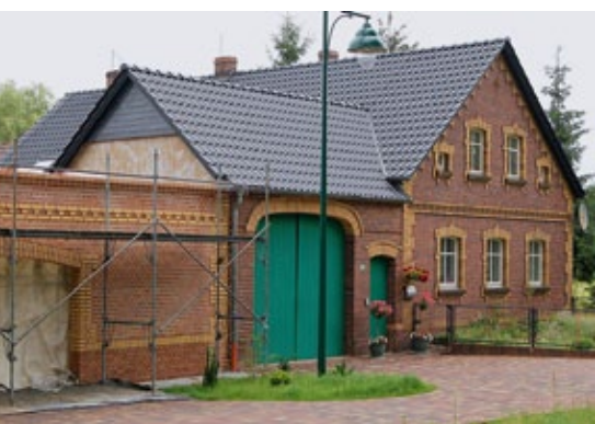
Neues Bauen in traditioneller Bauweise kann der Erhaltung des Ortsbildes dienen, verlangt aber »Fingerspitzengefühl« bei Gestaltung, Materialwahl und handwerklicher Ausführung (Bsp.: Klinkerbau in Bluno).
