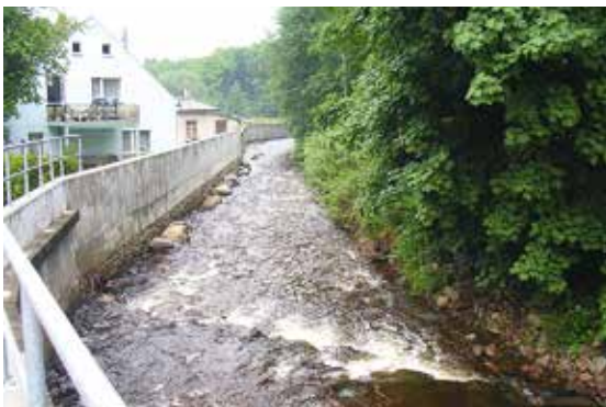
Hochwasserschutzwand an der Natzschung
