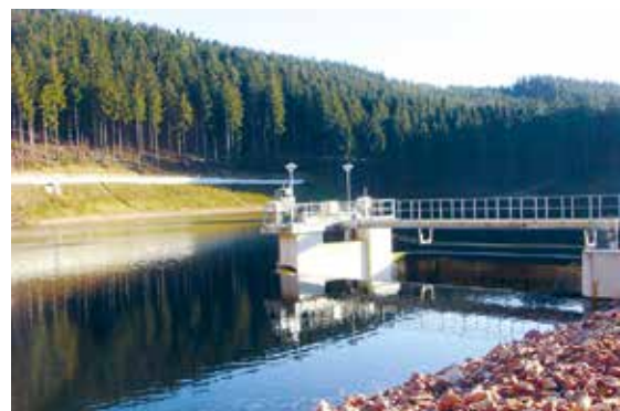
Talsperre Klingenberg – Überlauf Vorsperre.
