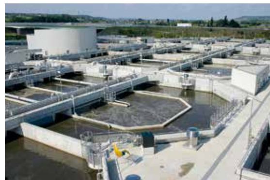
Neue biologische Abwasserbehandlung der Kläranlage Dresden-Kaditz
