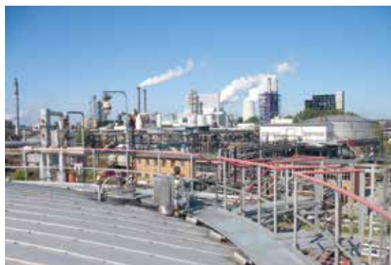
Bei großen Chemiebetrieben hat die Störfallvorsorge eine hohe Bedeutung.
