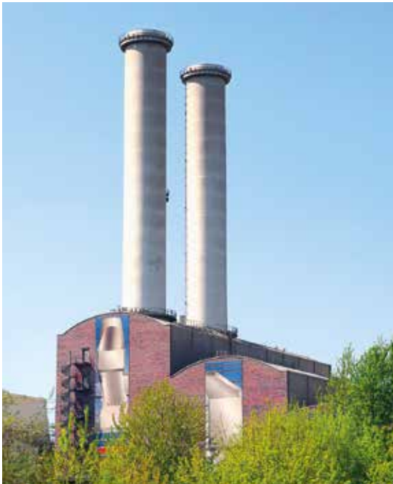
Blockheizkraftwerk einer Industrieanlage
