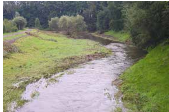
Naturnaher Gewässerausbau der Spree am Stausee Sohland
