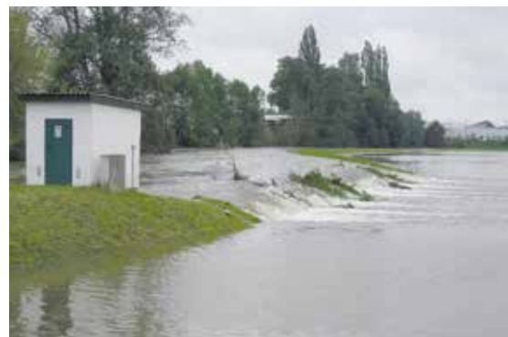
Hochwasser September 2010 in der Großen Röder, überströmter Deich am Pegel Kleinraschütz
