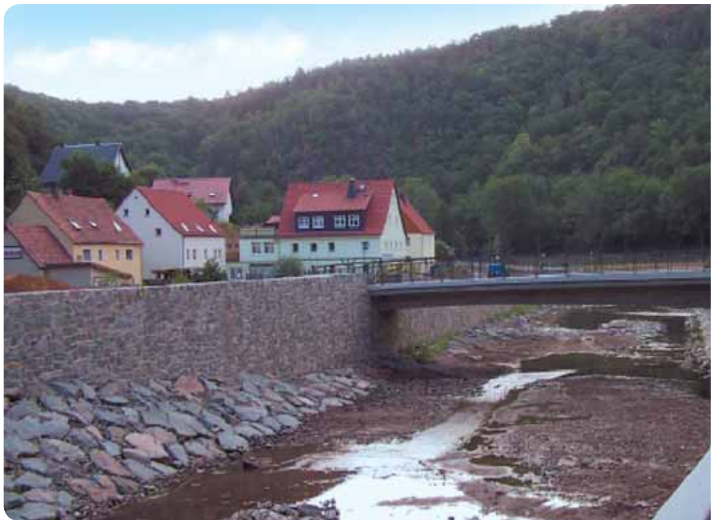
Müglitz - Weesenstein - Gerinneaufweitung und Mauererhöhung im Ortskern
