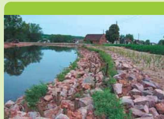
Böschungssicherung: Sedimentationsstrecke mit Weidensetzstangen
