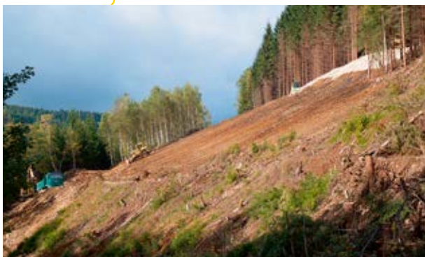
Sanierung einer Halde des ehemaligen Uranerzbergbaus
