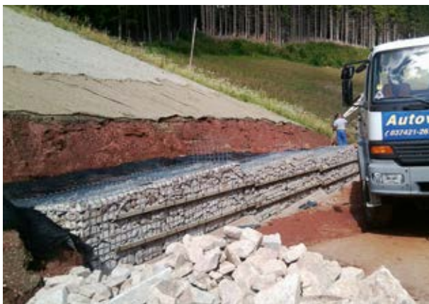
Sanierungsmaßnahme an einem Altstandort des Uranbergbaus.
