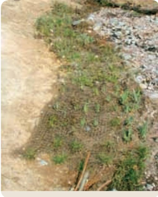
Bild 3.3.1: Vegetationswalze mit anschließender Hochstaudenpflanzung
