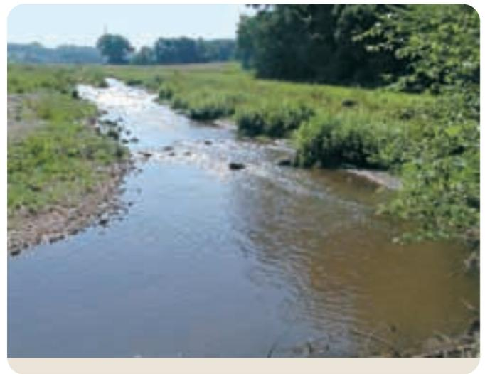
Bild 3.4.3.8: Drei Monate nach Beginn der Vegetationsperiode haben sich die Weiden der Buschbautraverse sehr gut entwickelt, auf den Anlandungen in den Bühnenfeldern führt Sukzession zur zunehmenden Verfestigung der neuen Uferlinie
