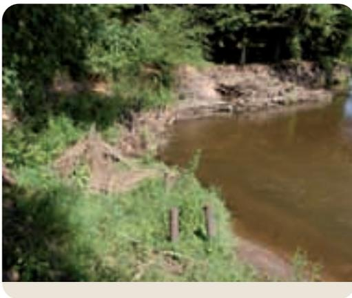
Bild 3.4.3.6: Im Schutz der Raubäume entwickelt sich ein neues Ufer, das durch Naturverjüngung aus Erlen und Weiden dauerhaft gesichert ist
