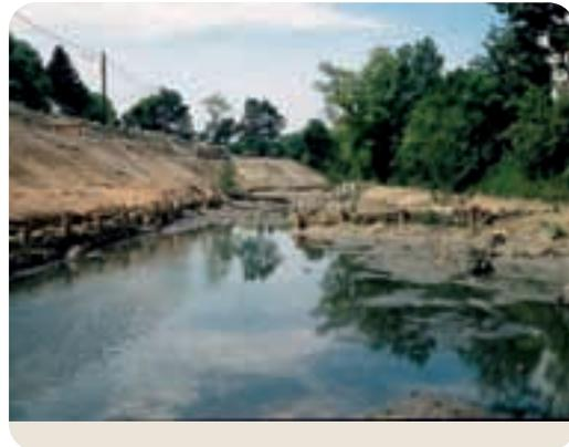
Bild 2.3.4: Neben der Sicherung der Uferböschungen werden ingenieurbio-logische Bauweisen zunehmend auch zur Gewässerstrukturierung bei Nieder- und Mittelwasser eingesetzt
