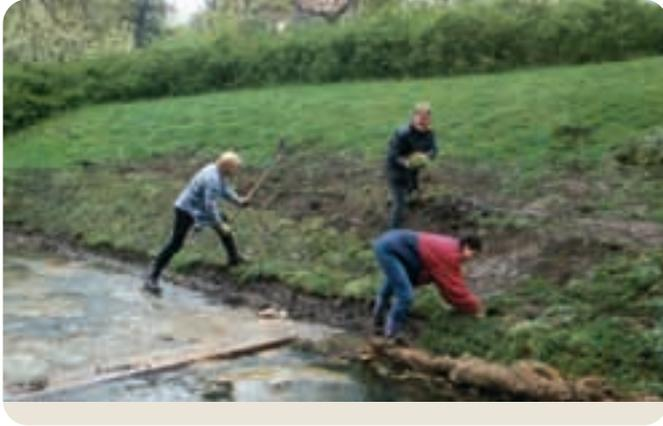
Bild 3.2.5: Auslegen und Einbauen der Rasensoden erfolgt in Handarbeit
