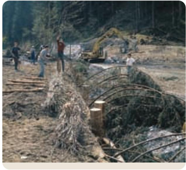
Bild 3.4.2.12: Einbau von Faschinen hinter einer Fußsicherung aus Raubäumen
