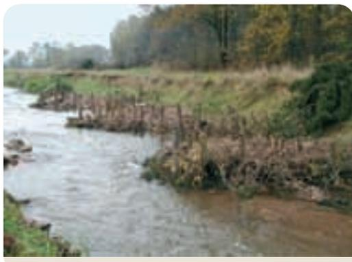
Bild 3.4.3.7: Fertiggestellte Buhne mit Buschbautraverse, sofort wirksamer Uferschutz und Strömungsberuhigung in den Bühnenfeldern
