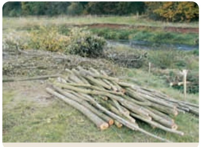
Bild 2.6.3.2: Die Aufbereitung des benötigten Baumaterials für ingenieurbioologische Bauweisen erfolgt möglichst direkt am Einbauort
