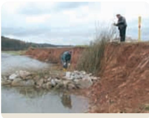
Bild 3.4.3.11: Buschbauleitwerk zum Bau einer Buhne
