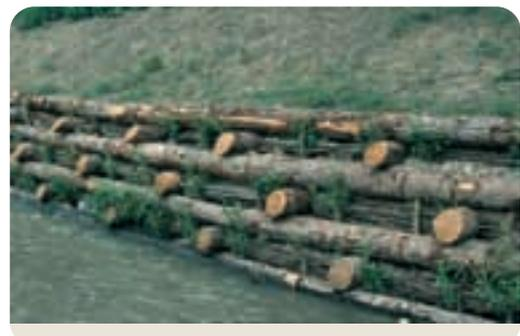
Bild 3.4.3.10: Sicherung der Zwischenräume zwischen den Längshölzern durch Faschinen
