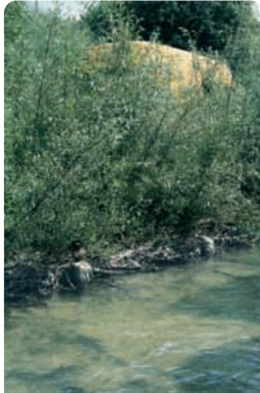
Bild 3.4.2.14: Die Faschinen aus Bild 3.4.2.13, 15 Monate nach dem Einbau
