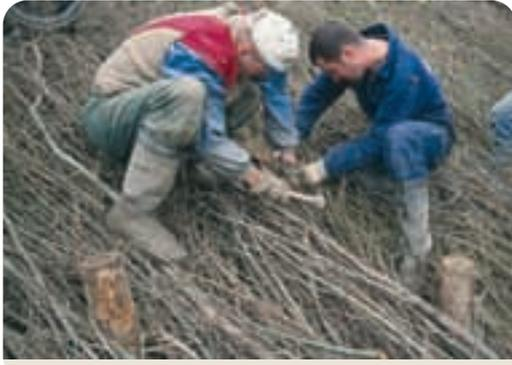
Bild 3.4.2.15: Spreitlagenbau – Befestigung der Weidenäste mit Bindedraht
