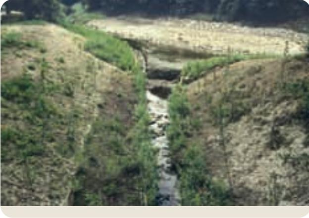
Bild 3.4.2.10: Der Flechtzaun (aus Bild 3.4.2.8) 3 Monate nach dem Einbau, hinter dem Flechtzaun erfolgt die Sicherung mit einer Böschungsschutzmatte und Stechhölzern
