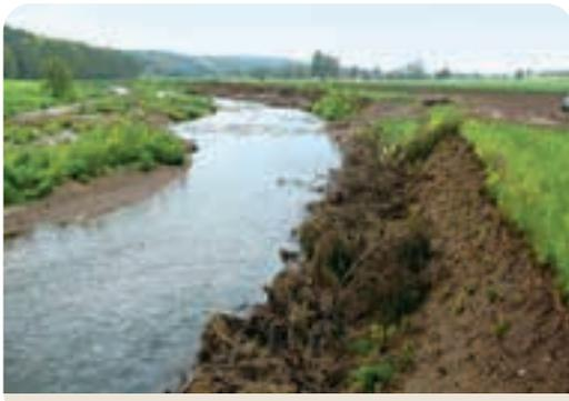
Bild 2.4.1: Raubäume sichern den Böschungsfuß linear; der daran anschließende Steckholzverbund wirkt in der Initialphase noch punktuell, später als flächige Böschungssicherung
