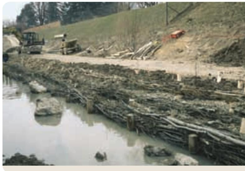
Bild 3.4.2.13 : Reihen aus Faschinen zur flächigen Böschungssicherung
