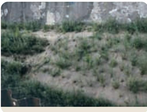
Bild 3.4.3.3: Begrünung und Befestigung einer Böschungsschutzmatte aus Kokosgewebe mit Stekhölzern
