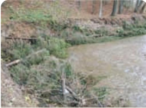
Bild 3.4.3.5: Sicherung des Prallufers durch Einbau von Raubäumen
