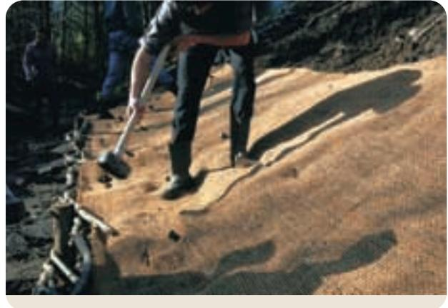
Bild 3.4.2.9: Unmittelbar im Anschluss an den Flechtzaun erfolgt die Böschungssicherung durch eine mit Steckhölzern begrünte Böschungsschutzmatte
