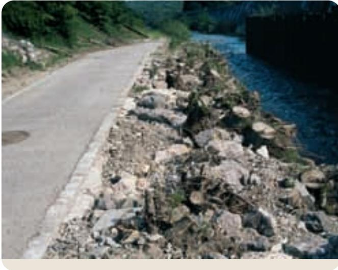
Bild 3.4.2.6: Einbau von Wurzelstöcken zur Böschungssicherung
