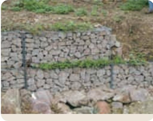
Bild 3.4.3.17: Begrünte Gabione – Austrieb der Buschlagen, 4 Wochen nach dem Einbau
