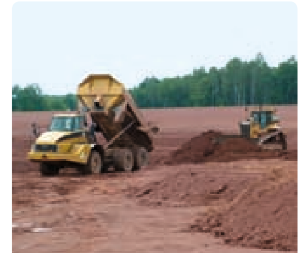
Abdeckung eines Schlammteiches des ehemaligen Uranerzbergbaus
