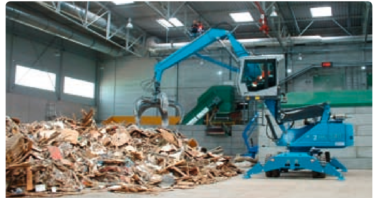
Annahme von Siedlungsabfällen in der Mechanisch-Biologischen Abfallbehandlungsanlage
