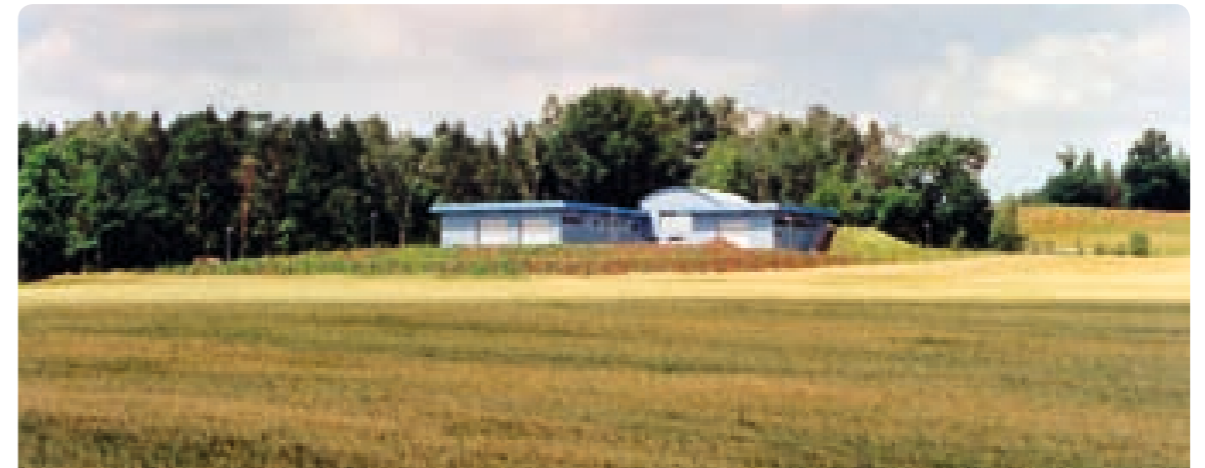
Wasserwerk Großhartau, Neubau 2004; Foto: ZV Bischofswerda RÖDERAUE
