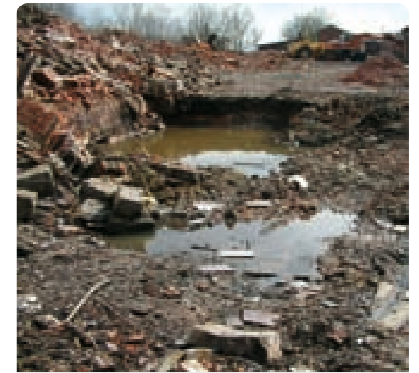
Steinkohlenmahlwerk Hohndorf, Abrissbereich; Foto: LfUG
