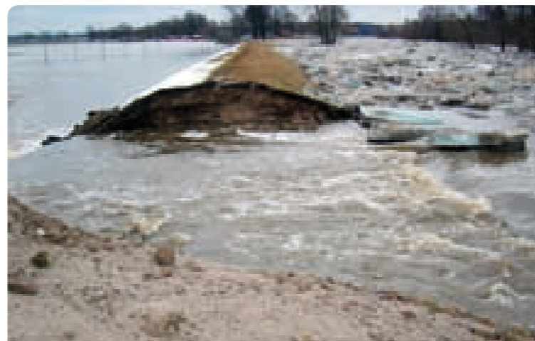
Deichöffnung am Deich der Schwarzen Elster ca. 350 m unterhalb der Brücke Tätzschwitz im Februar 2006
