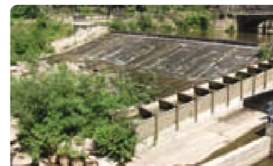
Kleinwasserkraftwerk Bienertwehr mit Fischtrappe
