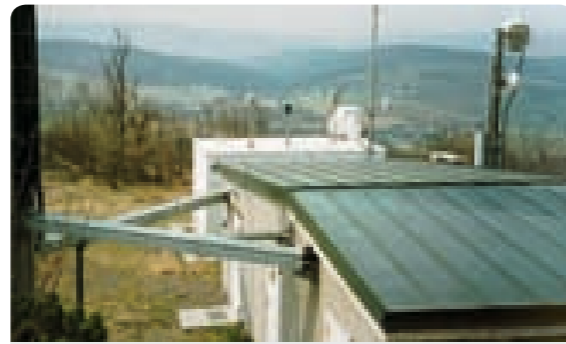
Luftmessstation der UBG auf dem Schwarzenberg; Foto: UBG
