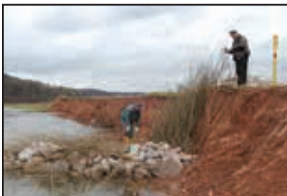
Abb. 8-10: Lebendbuhnen zum Schutz einer gewässerparallel verlaufenden Gasleitung sichern das Ufer vor weiterer Seitenerosion und verbessern gleichzeitig die Gewässerstruktur. Die Buhnen erhöhen die Strömungs- und Substratdiversität sowie Tiefen- und Breitenvarianz. Mit fortschreitender Vegetationsentwicklung werden sich aus den Buhnen standortgerechte Gehölzbestände entwickeln, die wiederum die Uferstruktur aufwerten, das Gewässer beschatten und regulierend auf die Wassertemperatur einwirken. Zwischen den Buhnen bleiben Uferabschnitte der Sukzession überlassen. Die ökologisch wertvollen Steilufer bleiben bis zur natürlichen Böschungsabflachung erhalten. In Gewässerabschnitten, in denen keine Infrastruktureinrichtungen, Grundstücksgrenzen oder Ähnliches zu schützen sind, wird der Lungwitzbach der eigendynamischen Entwicklung überlassen. (Fotos: Plan T - Planungsgruppe Landschaft und Umwelt, Radebeul)
