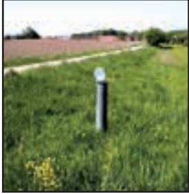
Grundwassermessstelle Volkersdorf 1 Staatliche Umweltbetriebsgesellschaft
