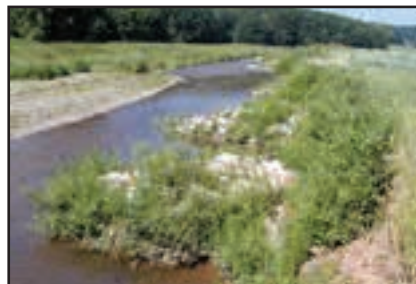
Abb. 8-10: Lebendbuhnen zum Schutz einer gewässerparallel verlaufenden Gasleitung sichern das Ufer vor weiterer Seitenerosion und verbessern gleichzeitig die Gewässerstruktur. Die Buhnen erhöhen die Strömungs- und Substratdiversität sowie Tiefen- und Breitenvarianz. Mit fortschreitender Vegetationsentwicklung werden sich aus den Buhnen standortgerechte Gehölzbestände entwickeln, die wiederum die Uferstruktur aufwerten, das Gewässer beschatten und regulierend auf die Wassertemperatur einwirken. Zwischen den Buhnen bleiben Uferabschnitte der Sukzession überlassen. Die ökologisch wertvollen Steilufer bleiben bis zur natürlichen Böschungsabflachung erhalten. In Gewässerabschnitten, in denen keine Infrastruktureinrichtungen, Grundstücksgrenzen oder Ähnliches zu schützen sind, wird der Lungwitzbach der eigendynamischen Entwicklung überlassen. (Fotos: Plan T - Planungsgruppe Landschaft und Umwelt, Radebeul)
