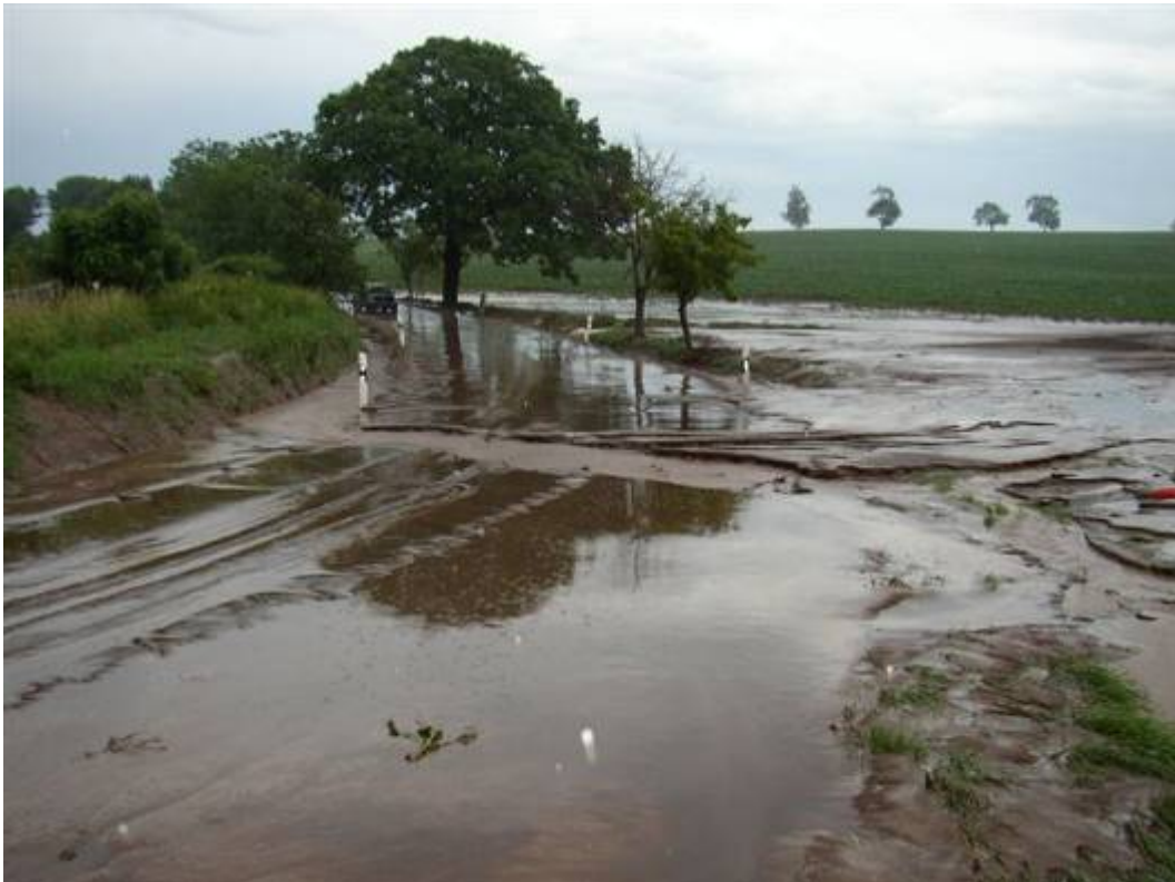
Abbildung 29: Verschlammung der Kohlenstraße am 15.06.2007 (Foto: Stadt Zwickau)
