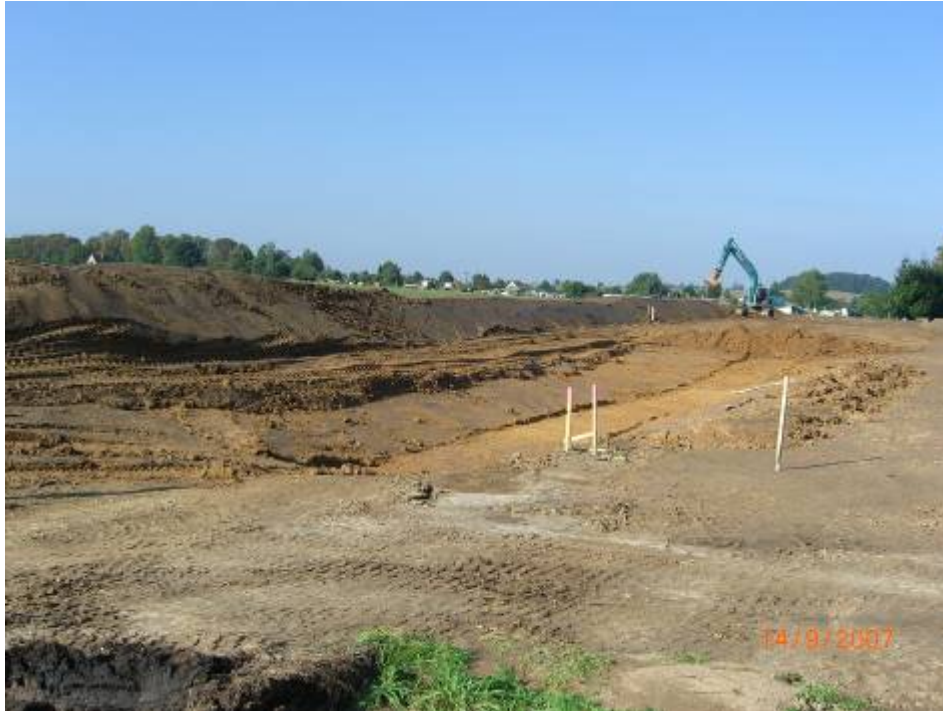
Abbildung 22: Dammbau im Bereich Viehbicht, Gemeinde Lohmen
