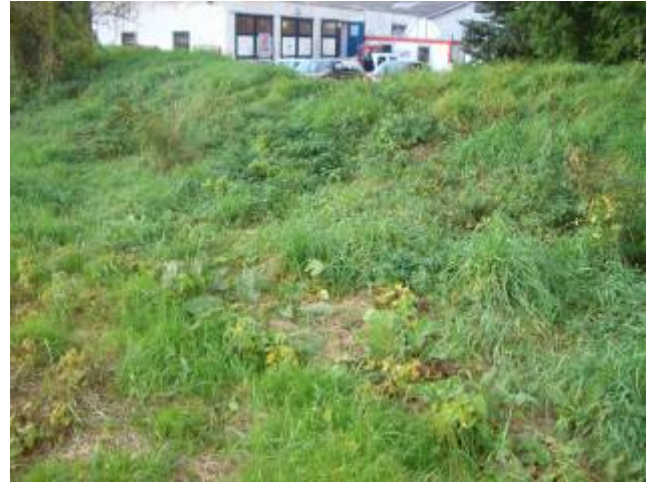
② Blick nach Nordwest
