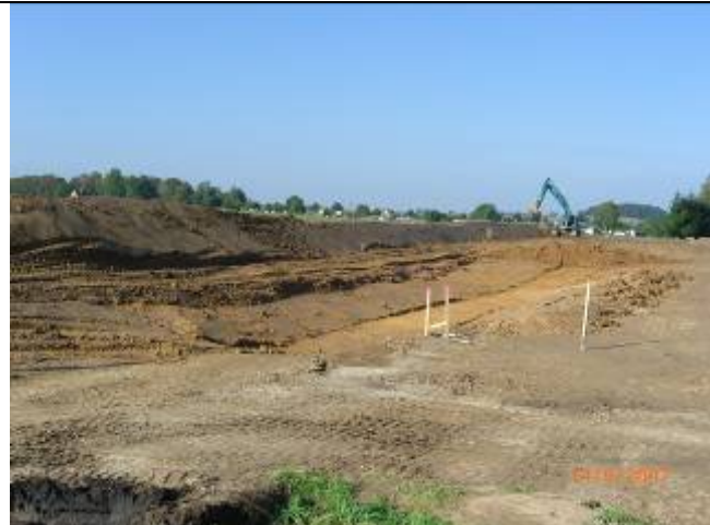
④ Blick nach Südwest
