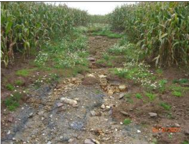
⑤ Blick nach Süden Auch im weiteren Verlauf unterhalb des Fuß- und Radweges ist eine Tiefenerosion bis auf das Festgestein vorhanden.
