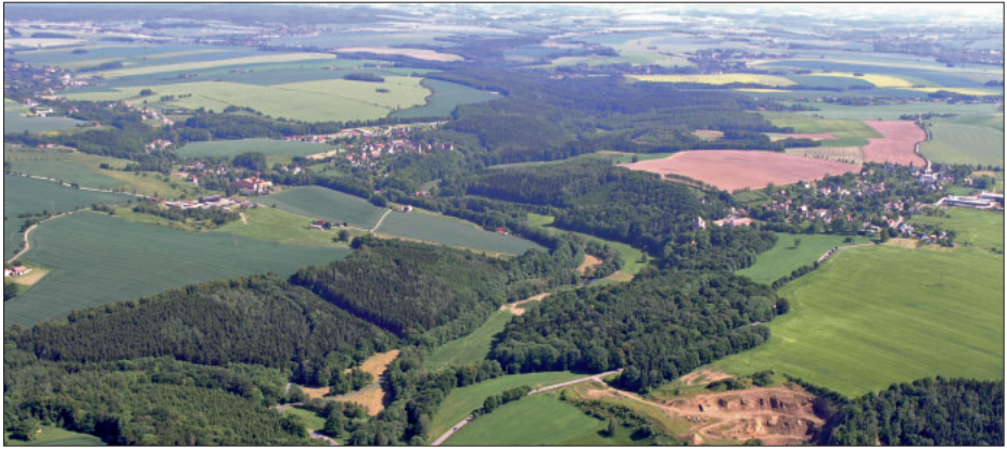
Abb. 4: Flusstäler wie hier an der Bobritzsch sind ein Beispiel für Biotopverbund
