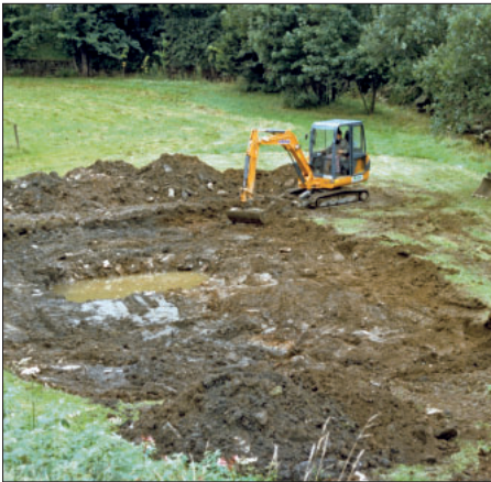
Abb. 5a: Baubeginn eines Laichgewässers in der Nähe der Naturschutzstation Pobershau Foto: R. Schorsch
