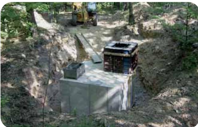
**Abb. 33:** Bauphase des Seismometerbunkers
