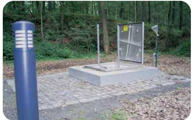
**Abb. 34:** Seismometerbunker mit Einstiegs Luke
