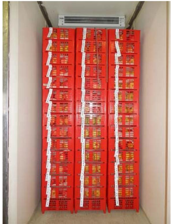
Abbildung 4: ULO-Zelle mit Gitterboxen gefüllt
