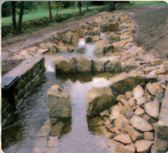
Wesentlich für das Vorkommen des Lachses ist die Durchgängigkeit geeigneter Gewässer. Fischaufstiegshilfe am Wehr des Lachsbaches. (Foto: Archiv LfUG, W. Fiedler)
