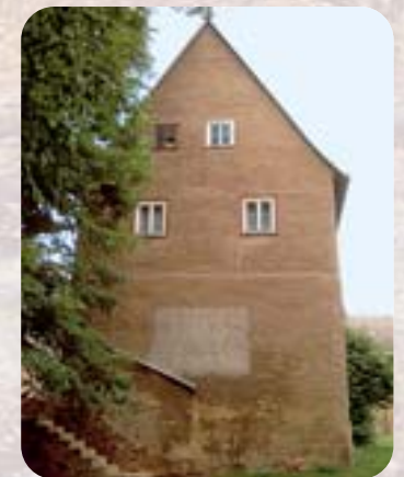
Wochenstube der Kleinen Hufeisennase mit freier Einflugöffnung im Giebel-fenster Foto: Ch. Schmidt
