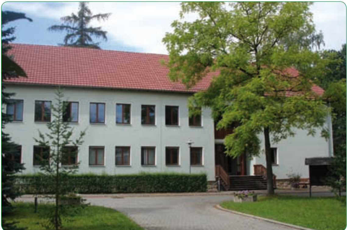
Bild 9.1: Sitz der Geschäfts- leitung des Staats- betriebes Sachsenforst in Pirna, Ortsteil Graupa, am Standort des ehemaligen Lan- desforstpräsidiums
