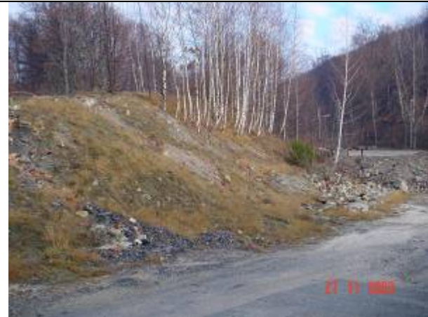
Abb. 2: Die ehemals vorhandene Halde aus Schutt und Produktionsabfällen
