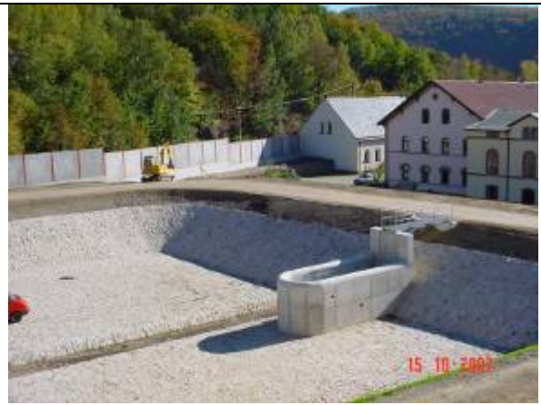
Oktober 2007: Teilansicht des Sedimentfangbeckens. In der Bildmitte der Schnabeleinlauf des Umflutungskanals. In „normalen“ Zeiten fließt das wenige Wasser des Rumpeltsbaches in einer Rinne durch das Becken.
