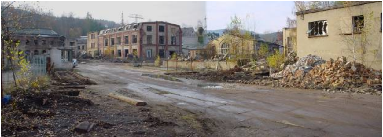
Abb. 1: Zustand vor der Revitalisierung im Jahr 2004. Foto u. Montage: Sehrig, Regierungspräsidium Chemnitz, Umweltfachbereich Plauen
