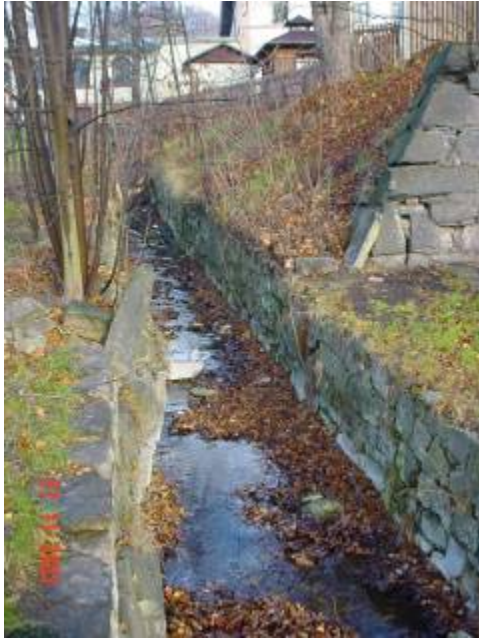
Abb. 1: Der kanalisierte Unterlauf des Rumpeltsbaches kurz vor Unterquerung der Clara-Zetkin-Straße Foto: Sehrig, Regierungspräsidium Chemnitz, Umweltfachbereich Plauen
