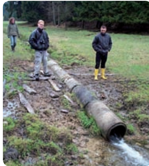
Verrohrung des Berghäuser Bachs Foto: Lange
