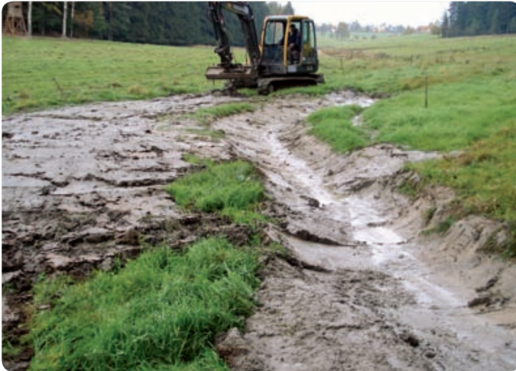
Baggerarbeiten während der Baumaßnahme Foto: Lange
