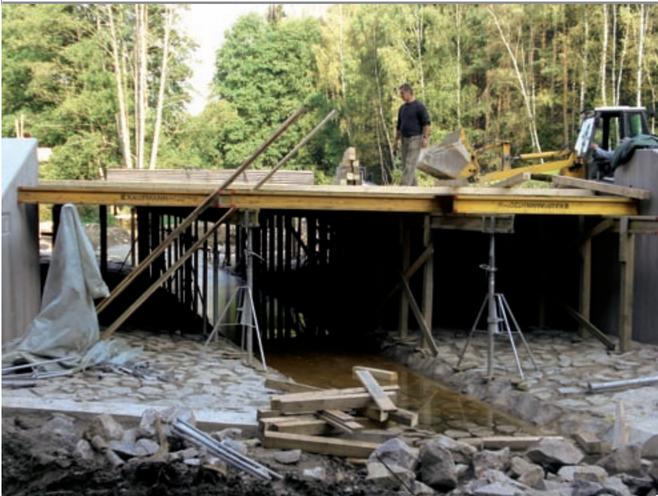
Ersatzneubau einer Brücke über den Haarbach Foto: Lange
