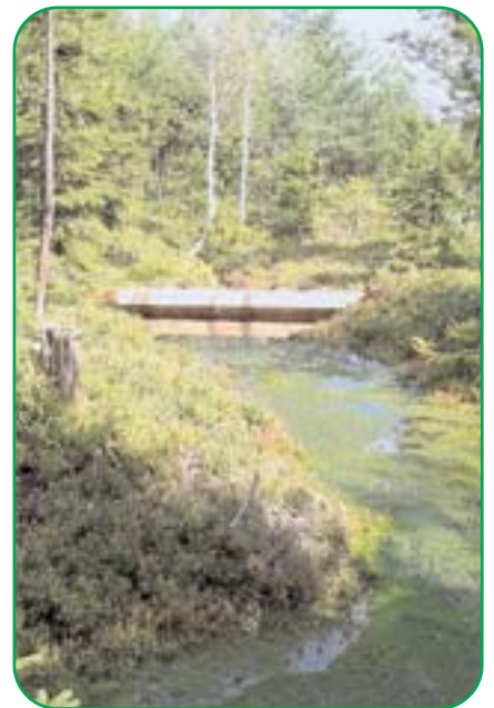
Abb. 13: Anstau eines alten Entwässerungsgrabens in der Hühnerheide, Forstbezirk Marienberg
