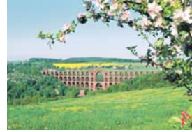
Göltzschtalbrücke im Vogtland, die größte Ziegelbrücke der Welt
