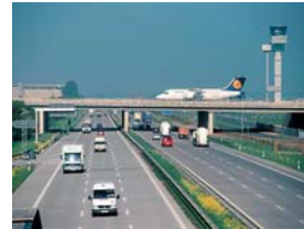
Die Autobahn A 14 bei Leipzig unterquert die Rollbahn des Flughafens
