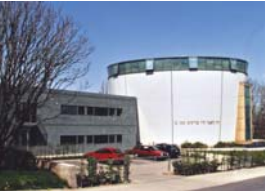
Die neue Synagoge in Chemnitz
