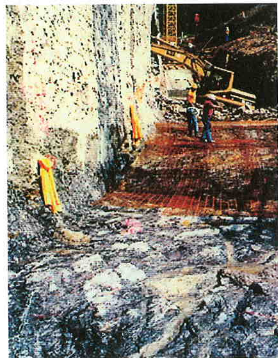
■ Abb. 8.2.1: Ingenieurgeologische Baugrundaufnahme der Sperrmauer Neunzehnhain II
