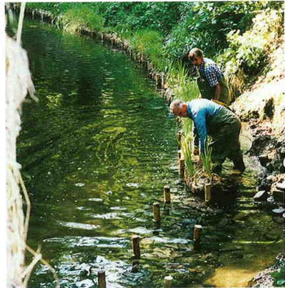
■ Abb. 3.7.3: Einbau von Röhrichtwalzen am Weißen Schöps 1995
