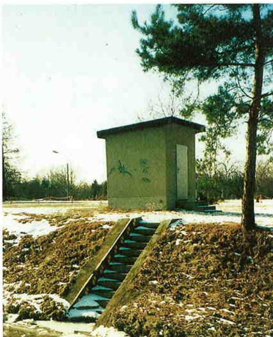
■ Abb. 3.2.7: Abflußpegel mit Funkübertragung der Daten
