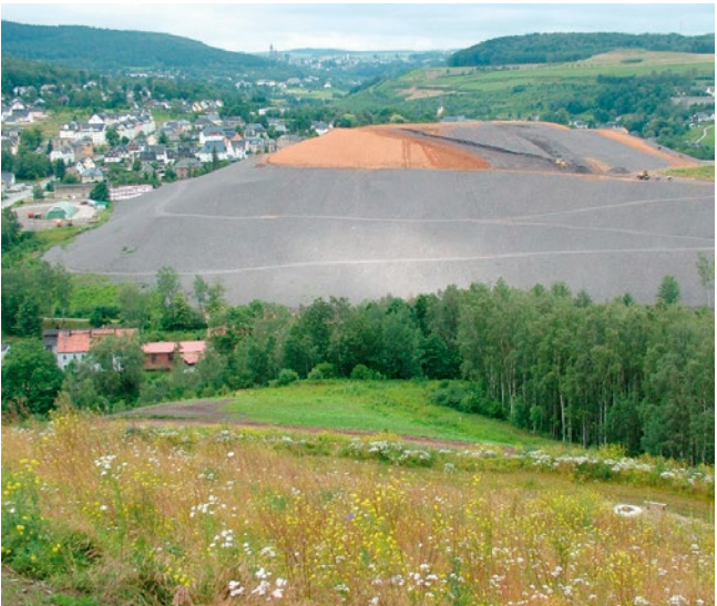
Profilierung und Abdeckung einer Halde des Uranerzbergbaus
