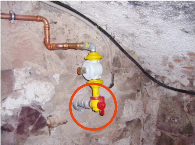
Mögliche Radon-Eintrittspfade in einem Keller an Leitungsdurchführungen und über das Mauerwerk
