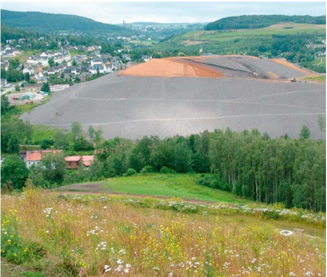
Profilierung und Abdeckung einer Halde des Uranerzbergbaus
