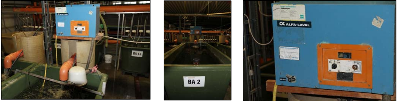
Abbildung 2: Kühlgerät ALFA LAVAL MK 403L (Leistung 1,5 KW) in den BA-Becken mit HSB-F1
