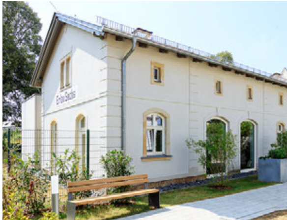
Die Sanierung erfolgte denkmalgerecht, historischer Bestand wurde bewusst kontrastierend herausgearbeitet.
