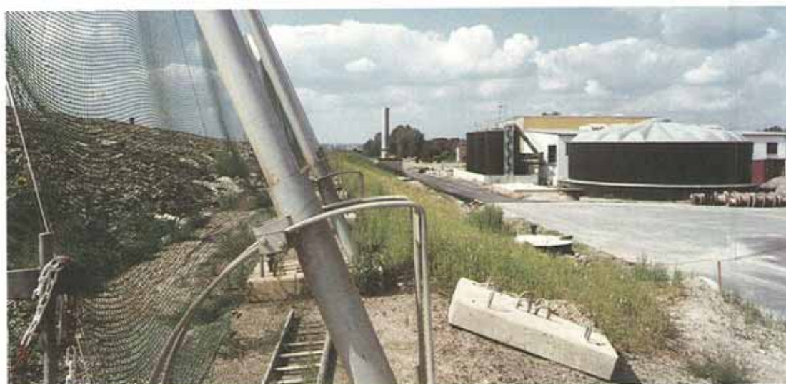
Abb. 3.22: Deponie mit Sickerwasser- behandlung
