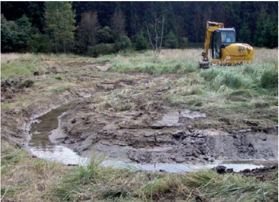
Abb. 10: Der zuvor stark begradigte Heubach im NSG „Sachsenwiese“ erhält im Zuge einer Kompensationsmaßnahme einen schlängelnden bis mäandrierenden Verlauf. Auf Grund fehlender Uferbefestigungen ist eine dynamische Gewässerentwicklung möglich.
