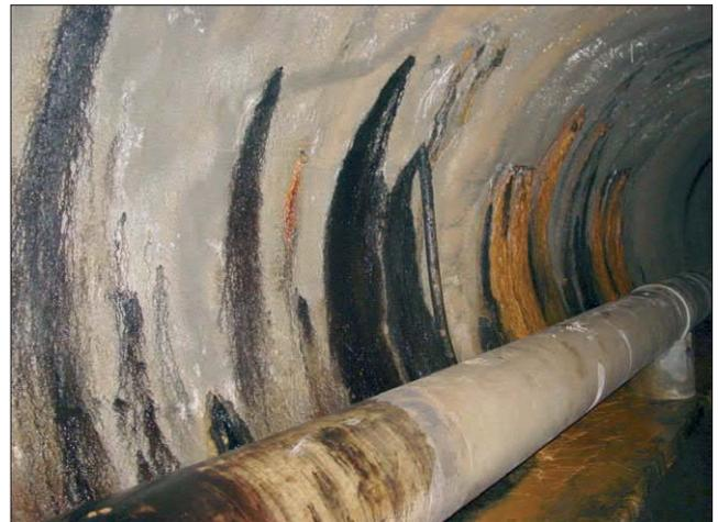
Abb. 18: Station 2205 m - intensive Sinterbildungen als Indiz für die Eibenstocker Störung
