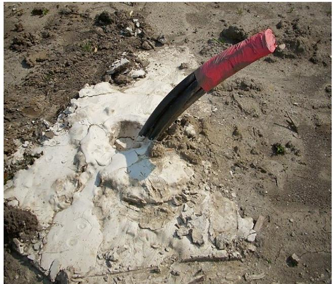
Abbildung 13: Eingebaute Erdwärmesonde
