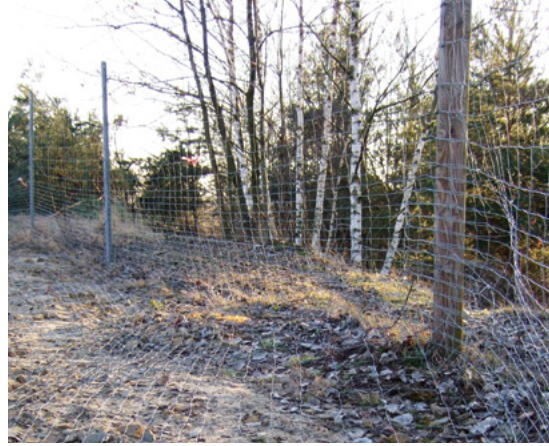
Unterwühlenschutz mit Knotengeflecht am Boden
