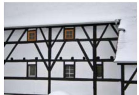
97 | Abgewandte Traufe mit wiederhergestelltem Langständergefüge. Die zugewandten Seiten sind hingegen in Stockwerkbauweise errichtet.
