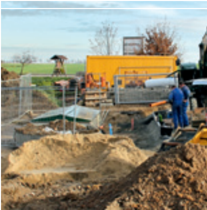
Kitzscher-Neudorf: Bauarbeiten für neue Kläranlage
