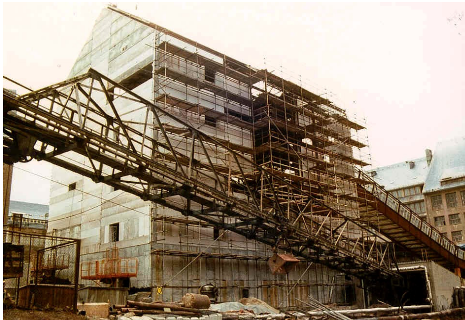
Abb. 160: 3. Brechstufe im Bau, davor Seilbahn nach Schwarzwasser Foto: J: RIBLAND
