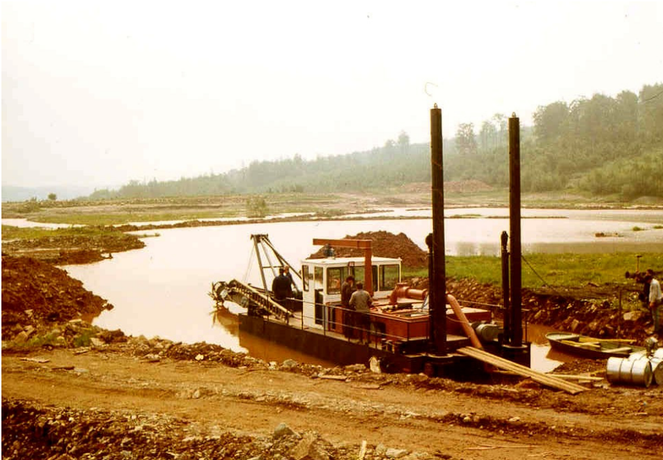
Abb. 169 : Saugschwimmbagger im Baggersee der Tiefenbachhalde Foto: H. Lausch
