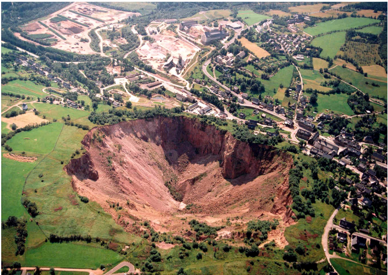
Abb. 183: Altenberger Pinge 1998 (450 x 350 x 110 m), Blick nach Süden: rechtsseitig Stadt Altenberg, Mitte oben Schacht 3 und Arno-Lippmann-Schacht, links oben Tiefenbachhalde
