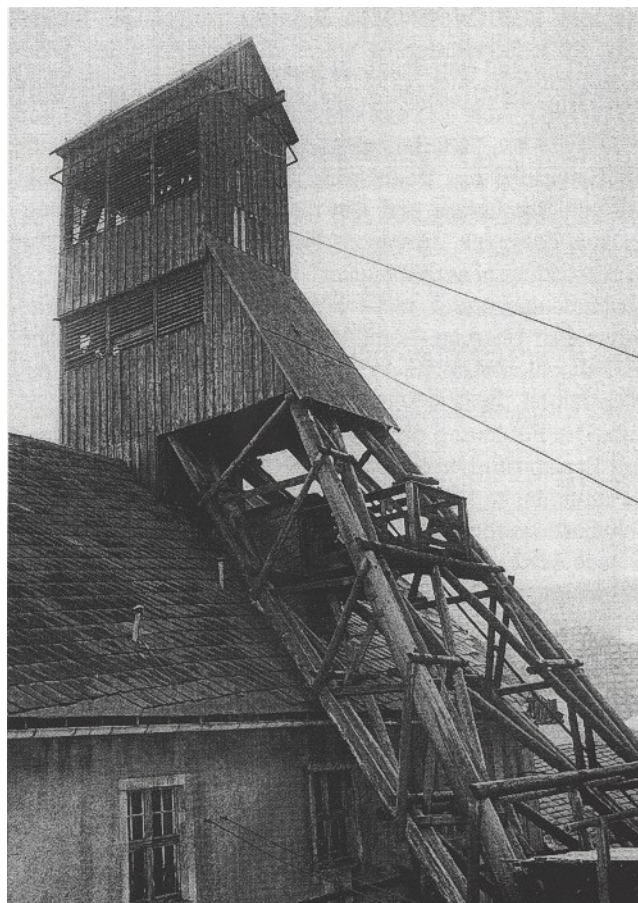
Abb. 12: Römerschacht, Förderturm mit Holzverstrebung und mit erhöhtem Seilscheibenstuhl Foto: 1983
