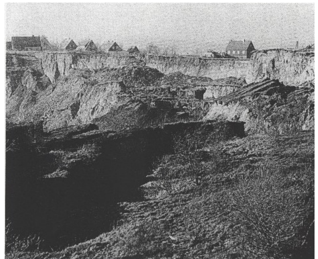
Abb. 33: Nordrand-Störungsbereich (Blickrichtung nach W), zerlegt sich durch forcierten Erzabzug in zahlreiche nach Süden (Pinge) driftende Schollen (Aufnahme 1984)
