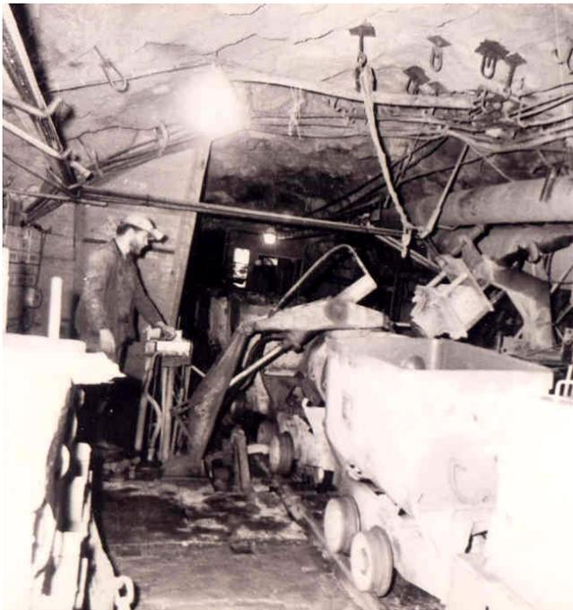
Abb. 120: Kippstelle für Förderwagen an der Brecheranlage 4 auf der 7. Sohle, 1987
