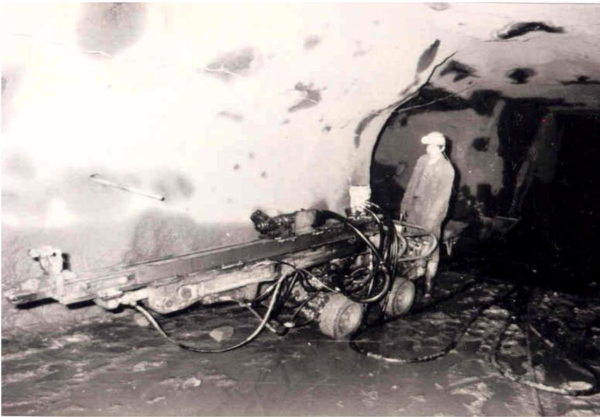
Abb. 131: Bohrwagen für kleinflächigen Abbau (Knäpperbohrungen), Wismut: BWKA, 1987
