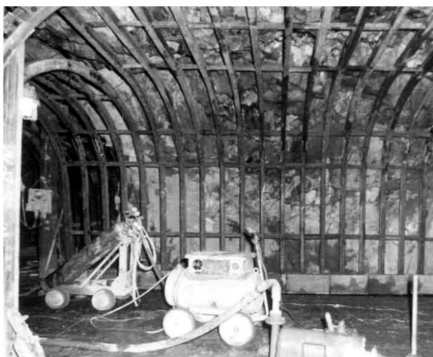
Abb. 103a: *Schwerer Stahlbogenausbau in der Ladestrecke 604: 1988*
