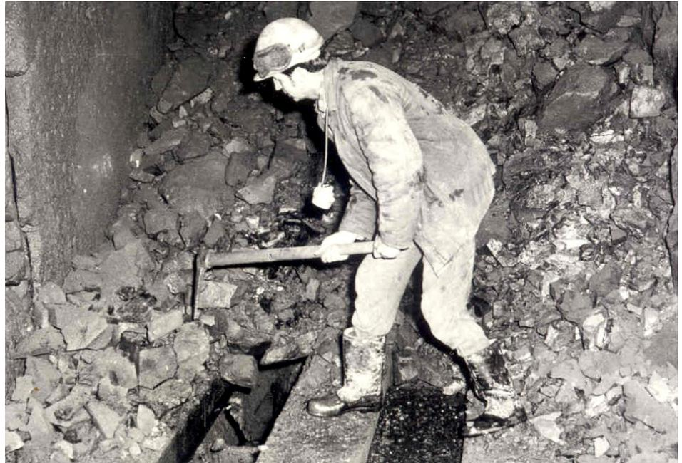
Abb. 115: Schubortabbau mit Schlitzrost, 1974
