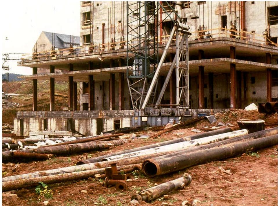
Abb. 152: Neue Aufbereitung, Beginn des Geschossbaus im Hubdeckenverfahren
