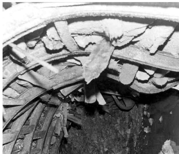
Abb. 103b: *Durch Gebirgsdruck „gefalteter“ Stahlbogenausbau, 3. Teilsohle 1987*
