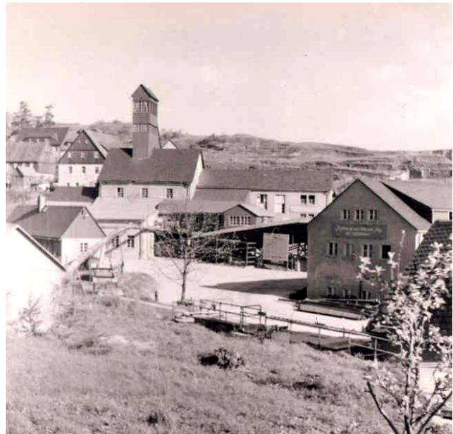
Abb. 122: Römerschacht mit vorgebauter Brecheranlage und Transportband in Aufbereitung Römer, 1965
