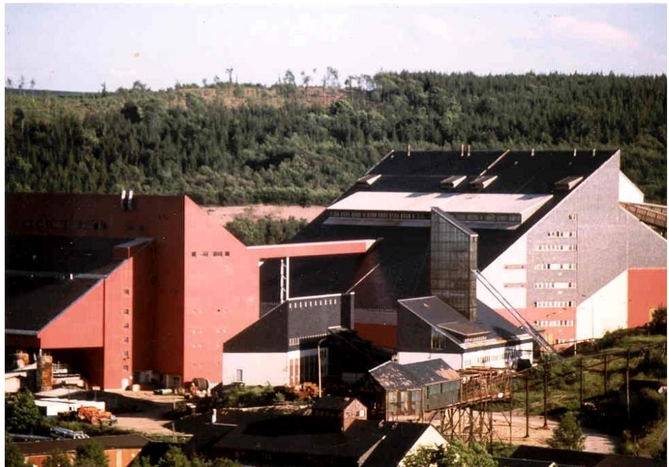
Eine begehbare Rohrbrücke von 60 m Länge stellte die Verbindung zwischen Neuer Aufbereitung und Neuer Flotation her. Beide Gebäude waren außen mit Ekotal verkleidet (= kunststoffbeschichtetes Feinblech von VEB Eisenhüttenkombinat Ost = EKO in Eisenhüttenstadt).
