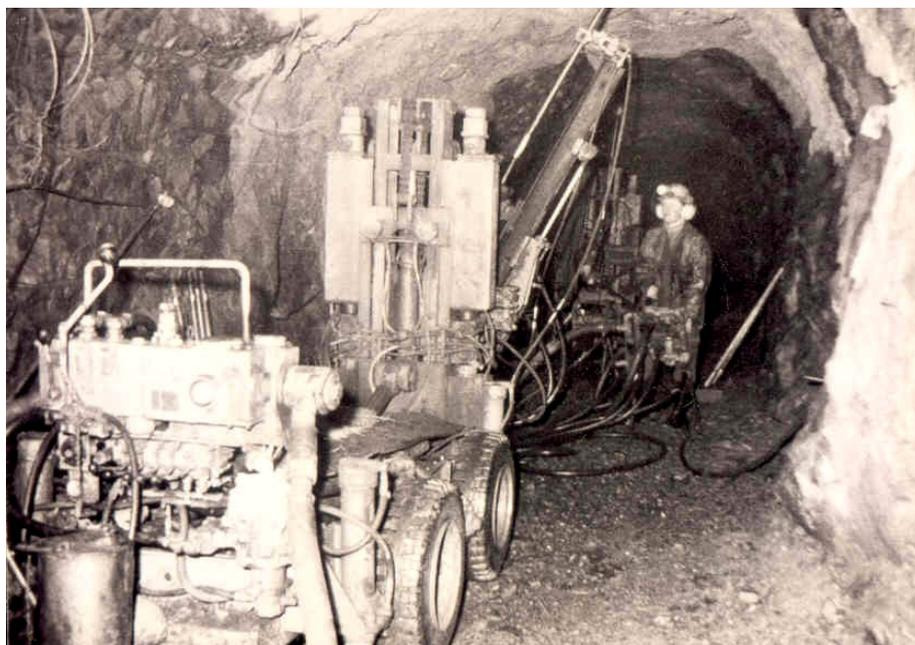
Abb. 130: Bohrwagen für Langlochbohrungen (Fächerbohrungen), Wismut: BWL, 1986
